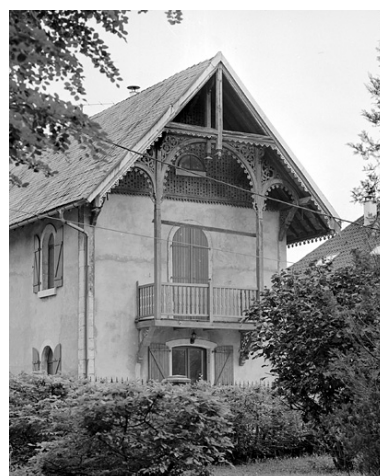
Détail du pignon de la conciergerie.
