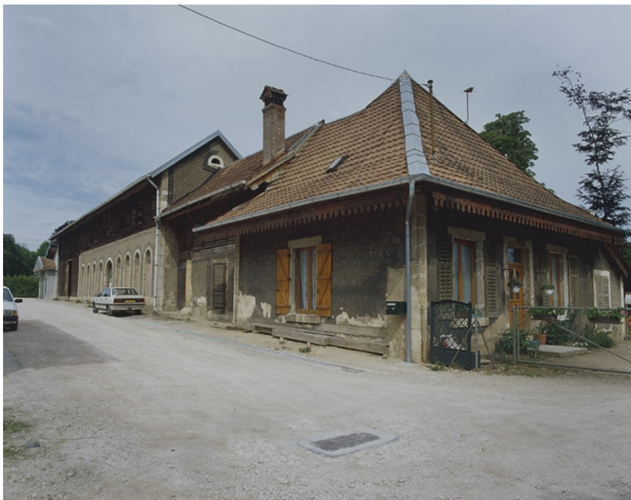
Orangerie et logement depuis l'est.
