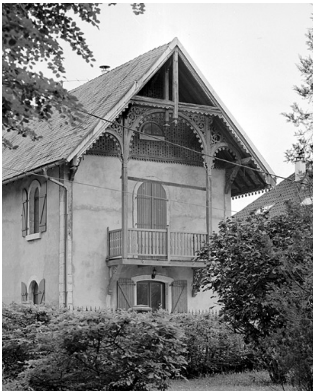
Détail du pignon de la conciergerie.
