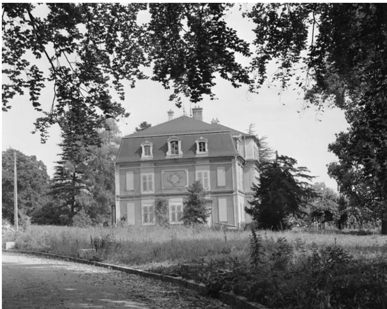
Façade ouest en 1981.SRI. Enquête régionale sur les bâtiments industriels (1979-1981).
