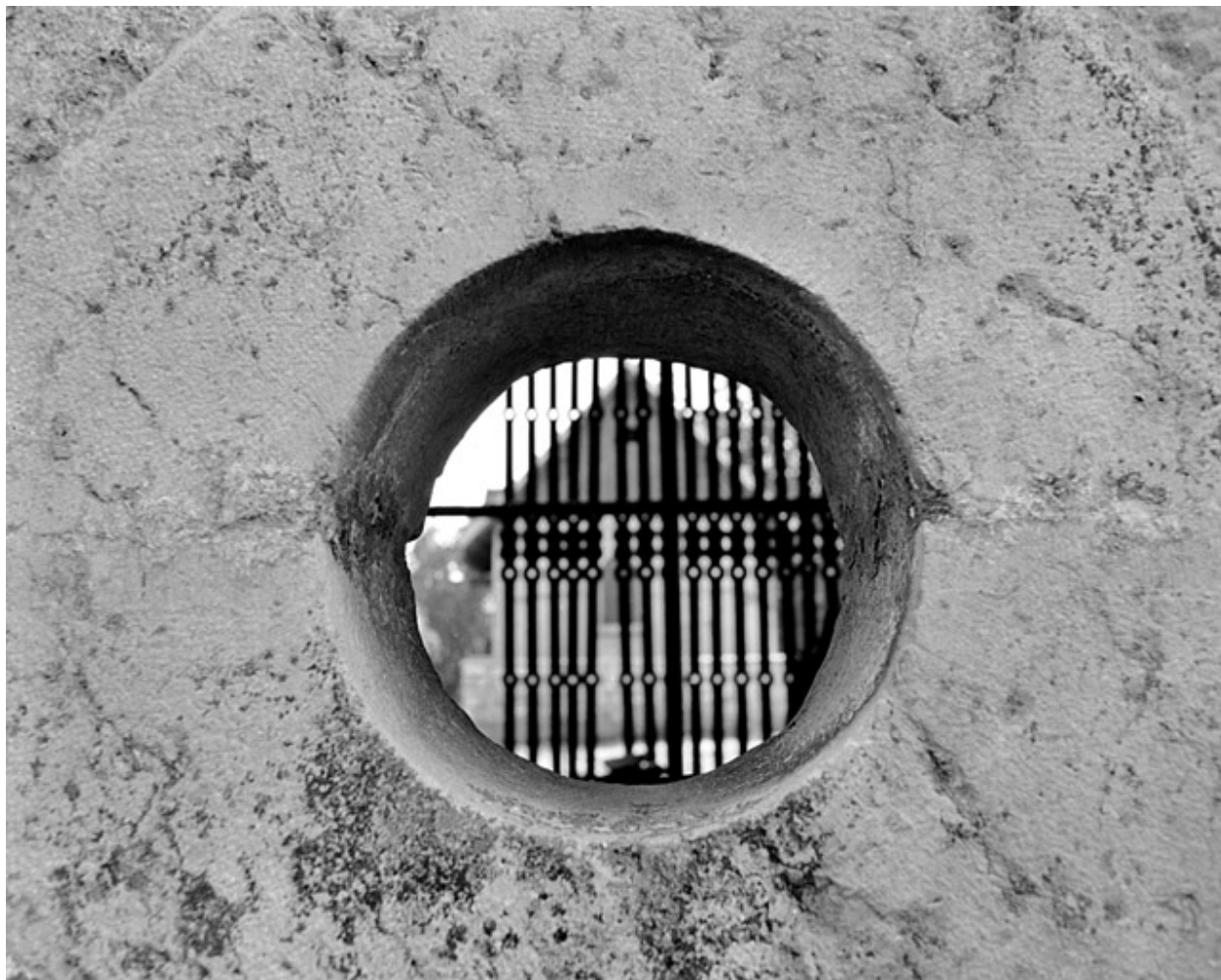
L'orangerie en 1981. Détail d'une baie d'aération.SRI. Enquête régionale sur les bâtiments industriels (1979-1981).
