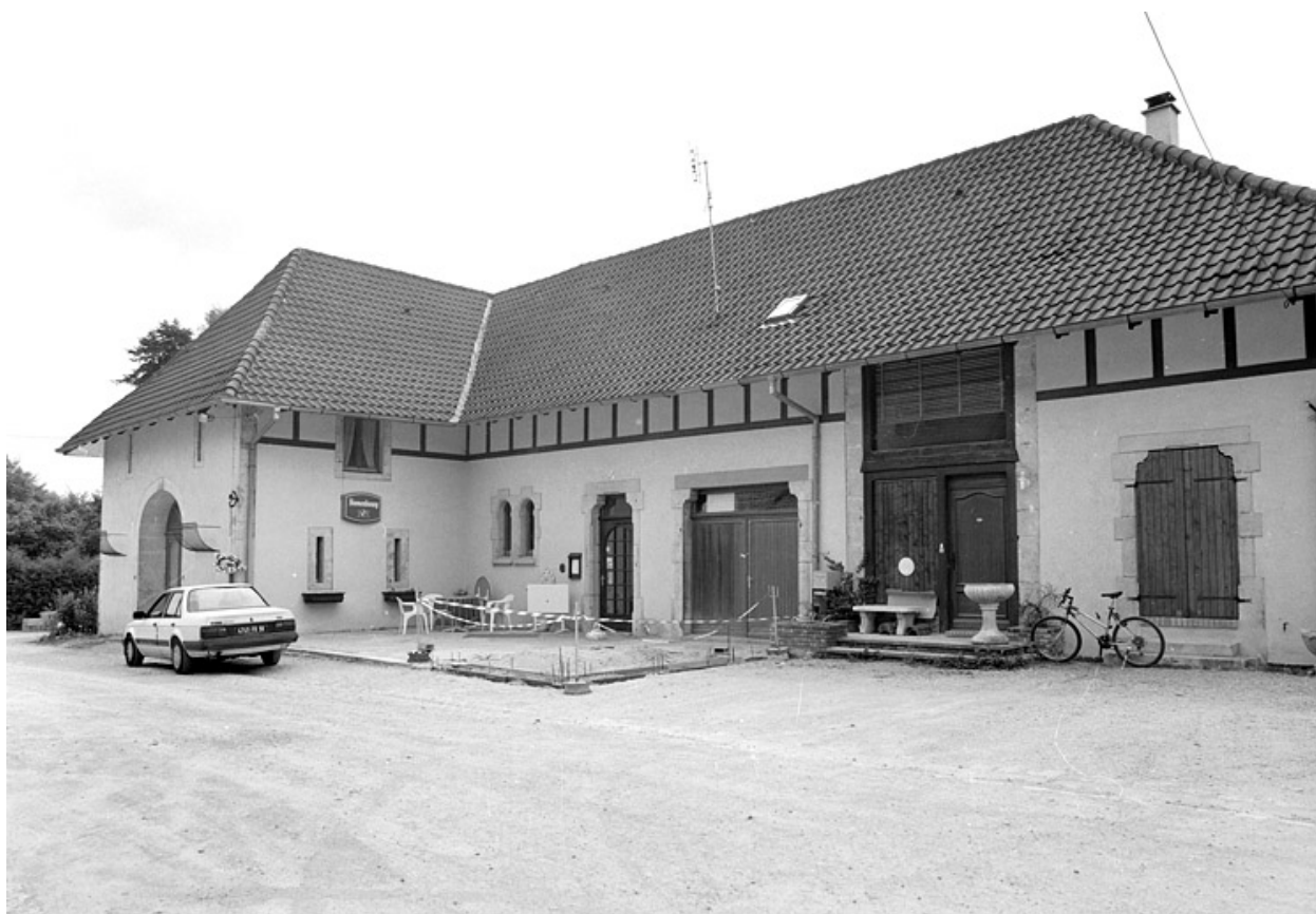
Bâtiment à usage agricole (étable, fenil).
