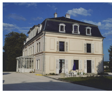
Vue de trois quarts arrière. Phot. Yves Sancey IVR43_20029000258XA
