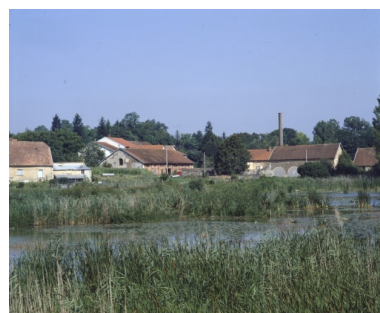
Vue de l'usine métallurgique depuis l'étang en 1989. Phot. Yves Sancey IVR43_19897000822XA
