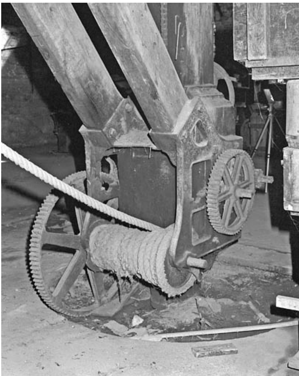
Grue à potence. Détail de la base.
