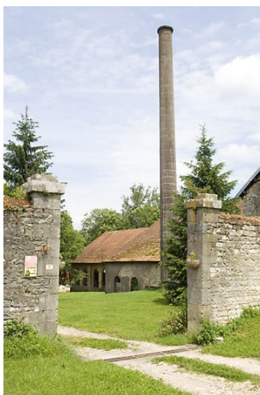
Entrée de l'usine. Phot. Jérôme Mongreville IVR43_20087000947NUC2A
