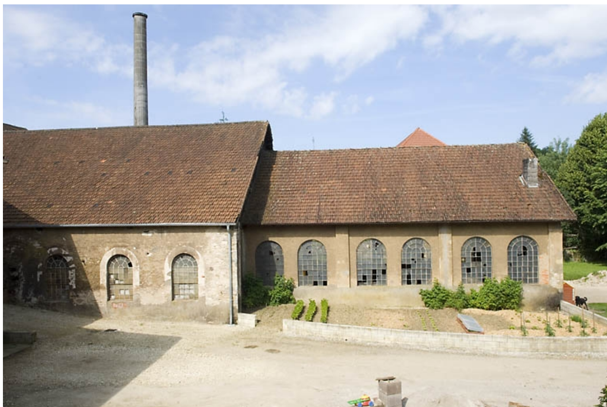
Façade est de l'atelier de fonderie.
