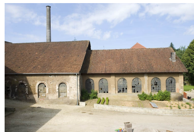
Façade est de l'atelier de fonderie. Phot. Jérôme Mongreville IVR43_20087000945NUC2A
