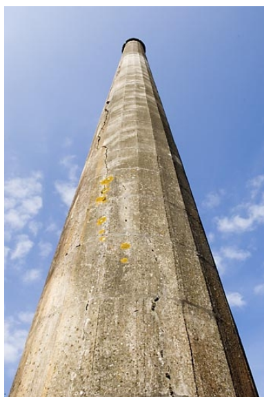
Cheminée vue en contre-plongée (1). Phot. Jérôme Mongreville IVR43_20087000943NUC2A
