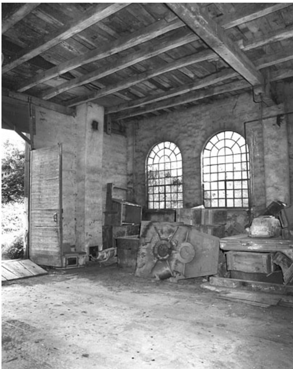
Angle nord de l'atelier de fabrication en 1981.
