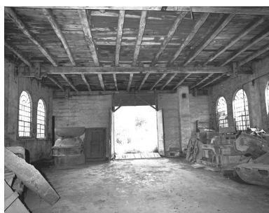
Partie sud de l'atelier de fabrication en 1981. Phot. Jérôme Mongreville IVR43_20097000103X
