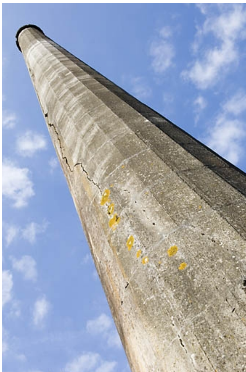
Cheminée vue en contre-plongée (2).
