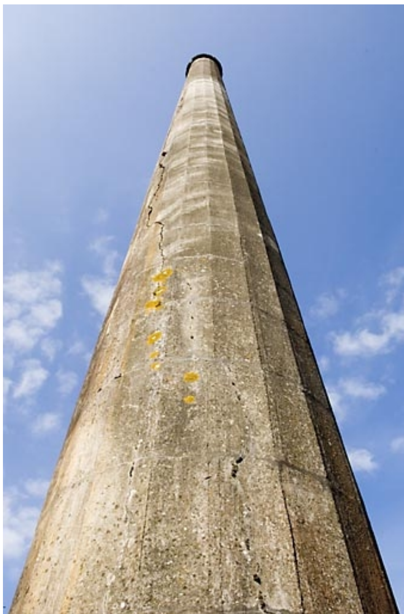
Cheminée vue en contre-plongée (1).
