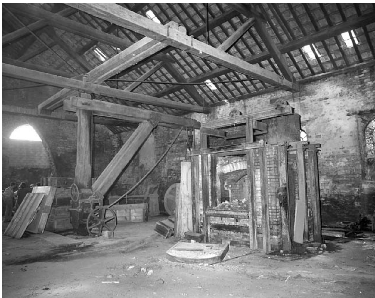
Vue d'ensemble de l'atelier de fabrication en 1981.
