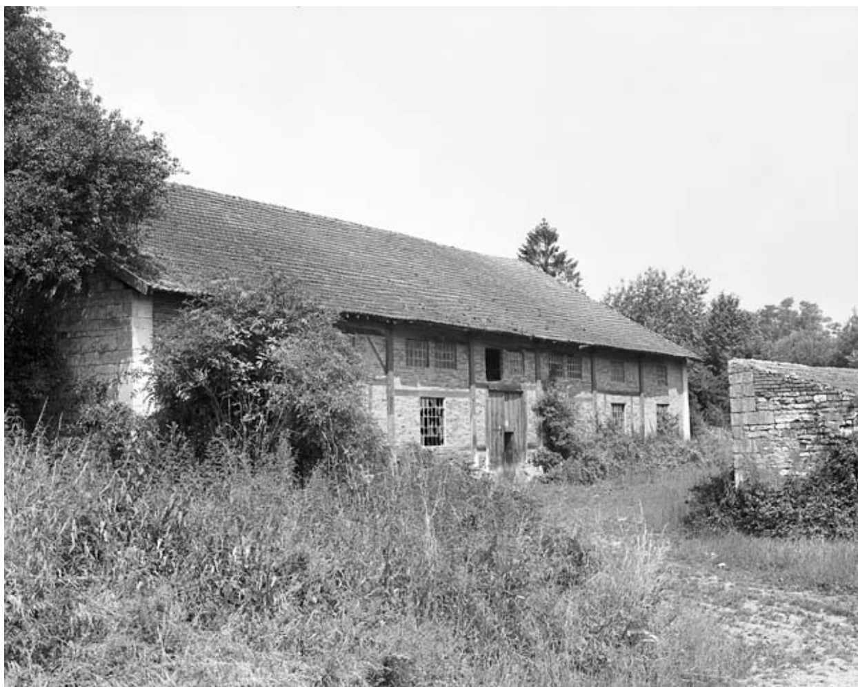
La halle à charbon en 1981.
