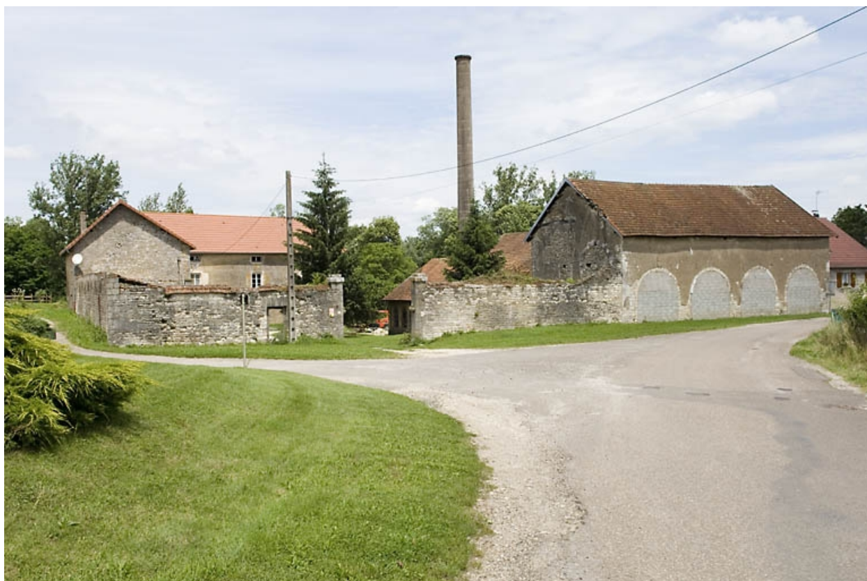
Vue d'ensemble depuis le sud.
