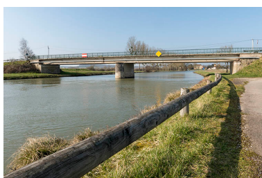
Pont routier franchissant la rivière. Phot. Sonia Dourlot IVR43_20167000287NUC4A
