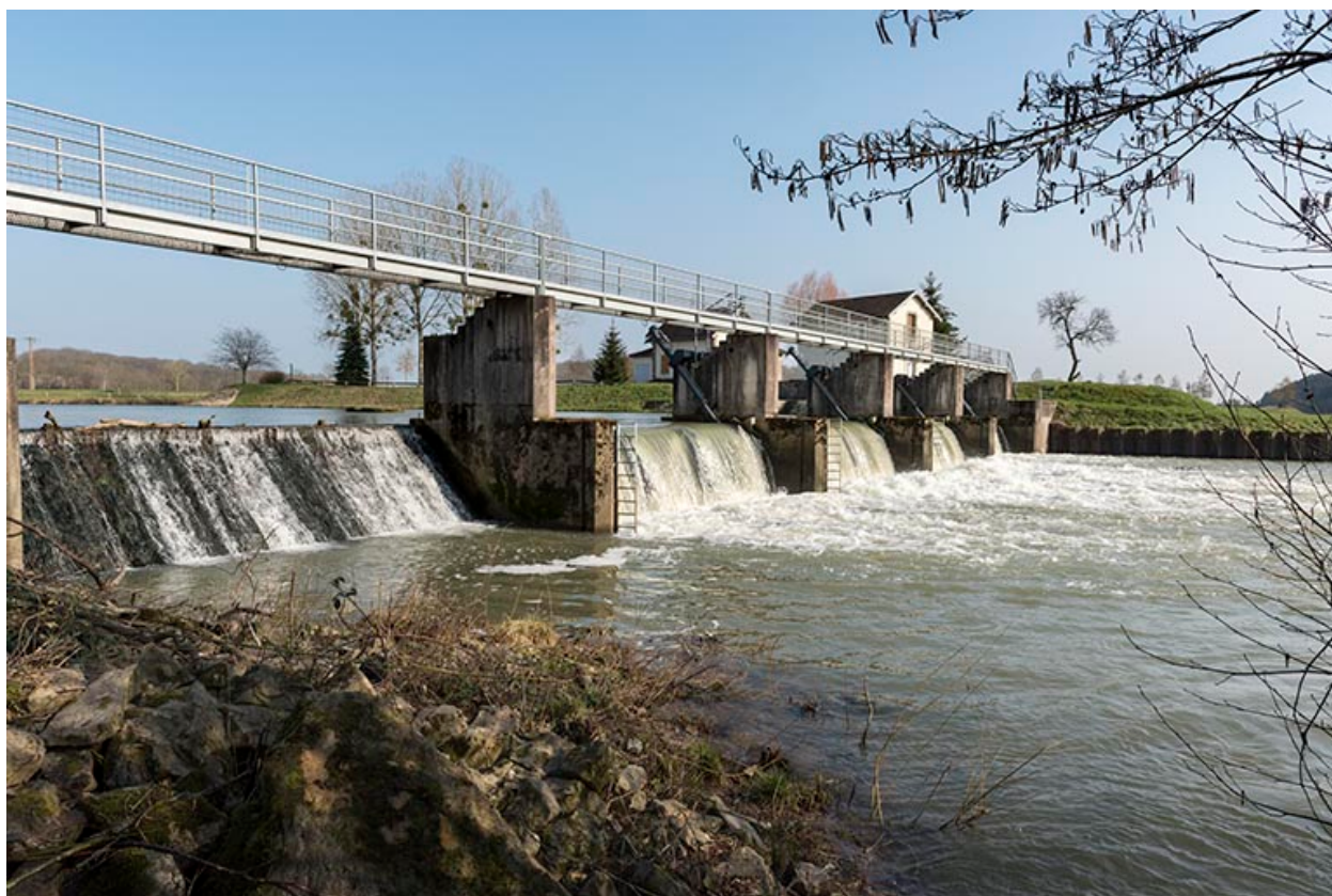
Le barrage mobile de Montureux-lès-Baulay.
