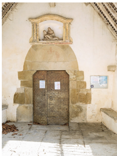
Vue d'ensemble avec la porte. Phot. Pierre-Marie Barbe-Richaud IVR26_20177100108NUC2A
