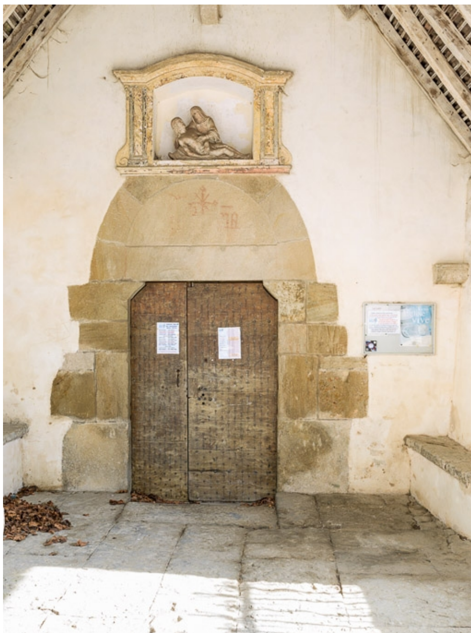
Vue d'ensemble avec la porte.
