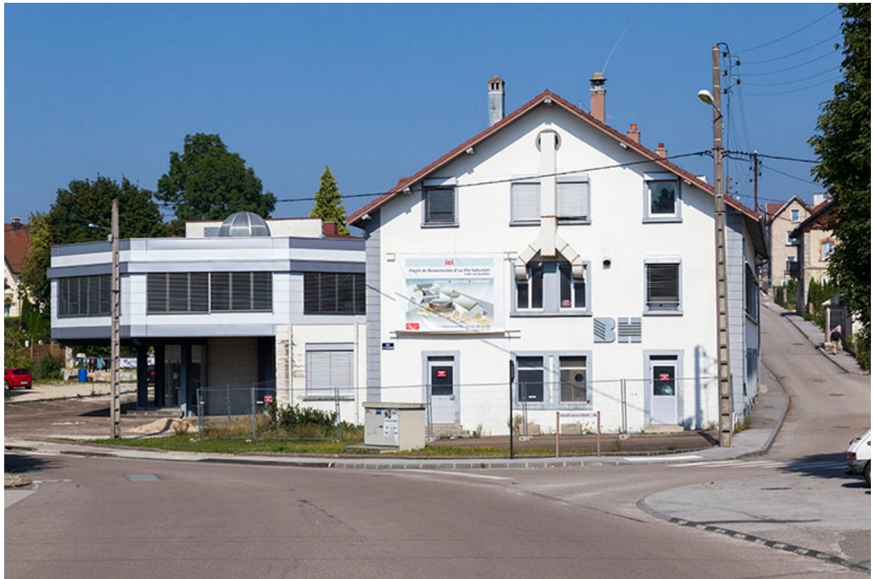
Corps d'entrée et usine, vus de l'est.
