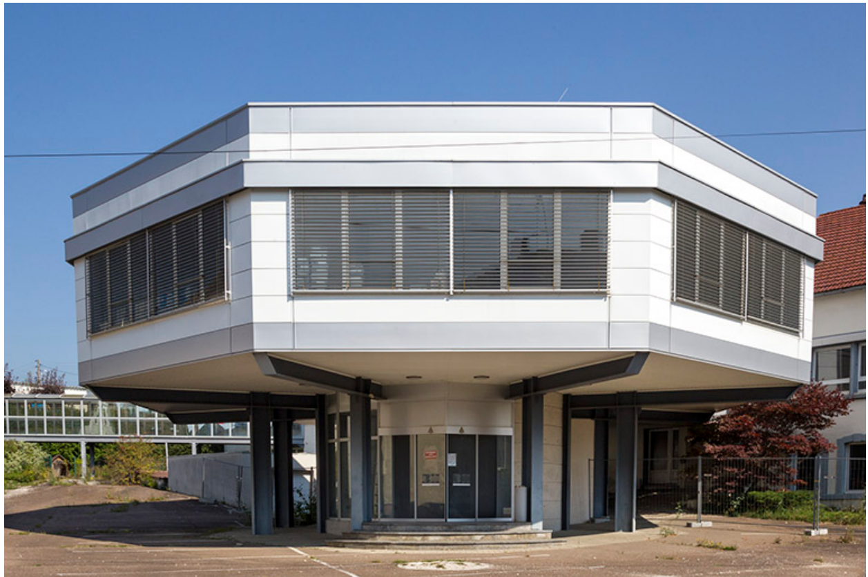
Usine : corps d'entrée.
