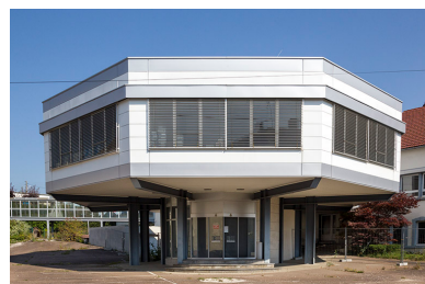
Usine : corps d'entrée.
