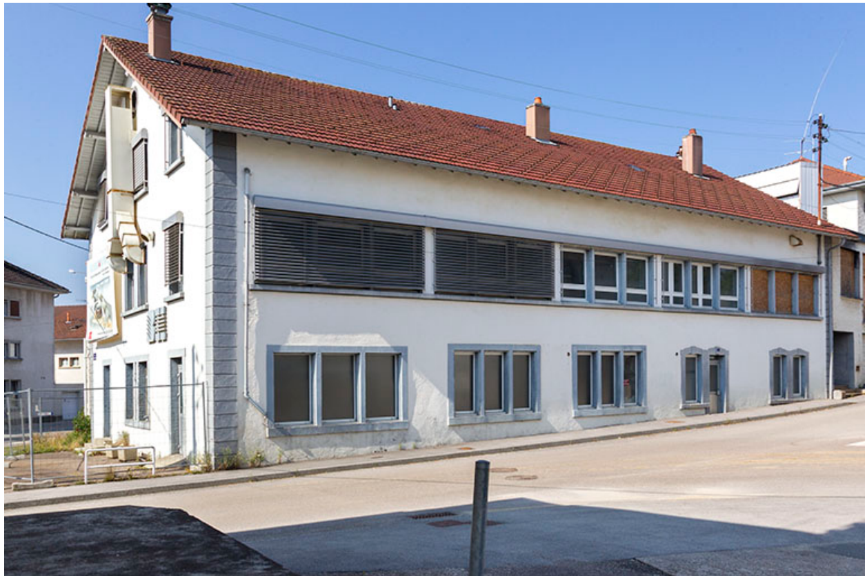
Usine, 1er corps de bâtiment : façade antérieure.
