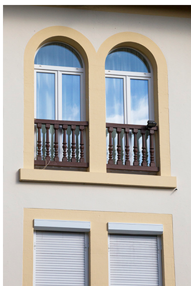
Logement patronal, façade méridionale : fenêtres. Phot. Yves Sancey IVR43_20132502047NUC2A
