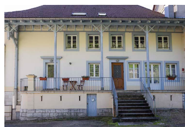
Premier atelier de fabrication : façade antérieure. Phot. Yves Sancey IVR43_20132502056NUC2A
