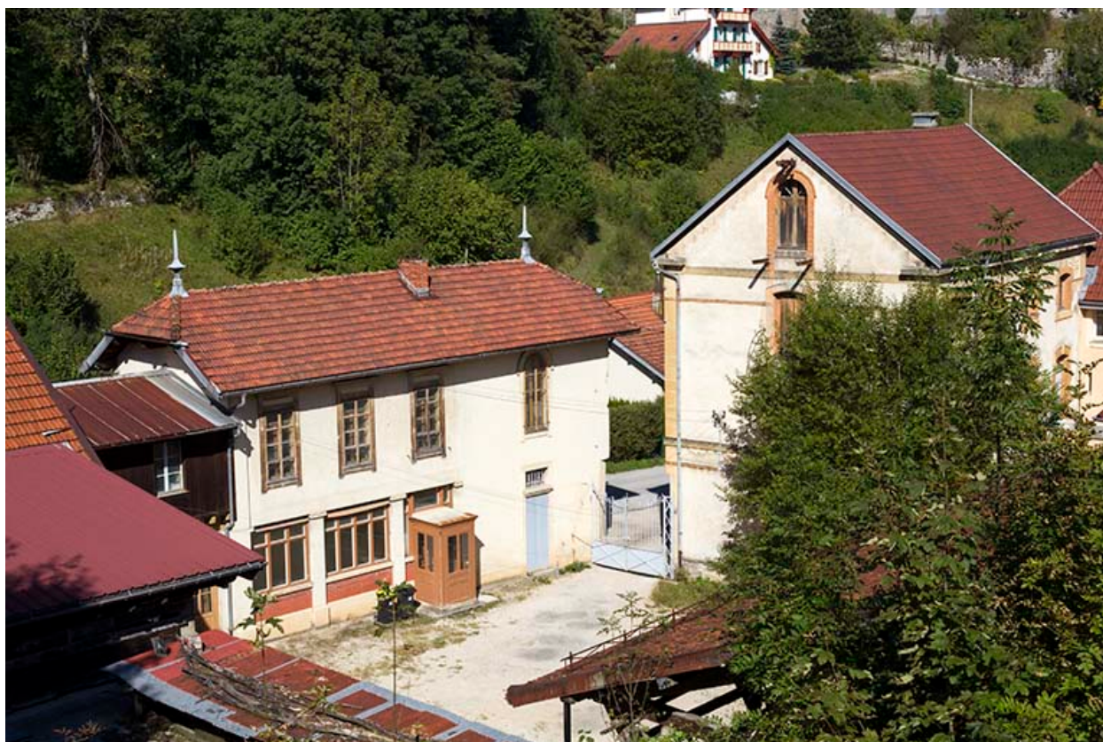
Bureau et laboratoire : façade sur cour.
