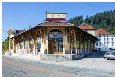
Atelier de conditionnement et quai. Phot. Yves Sancey IVR43_20132502053NUC2A
