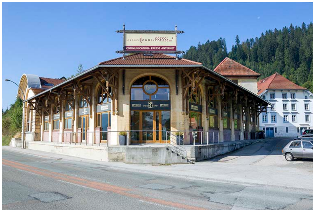
Atelier de conditionnement et quai.
