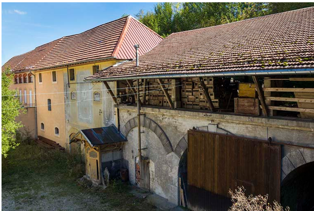
Entrepôt industriel (extrémité occidentale) et magasin industriel.
