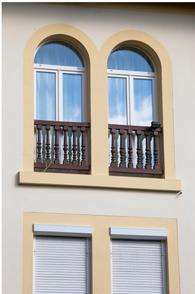
Logement patronal, façade méridionale : fenêtres.
