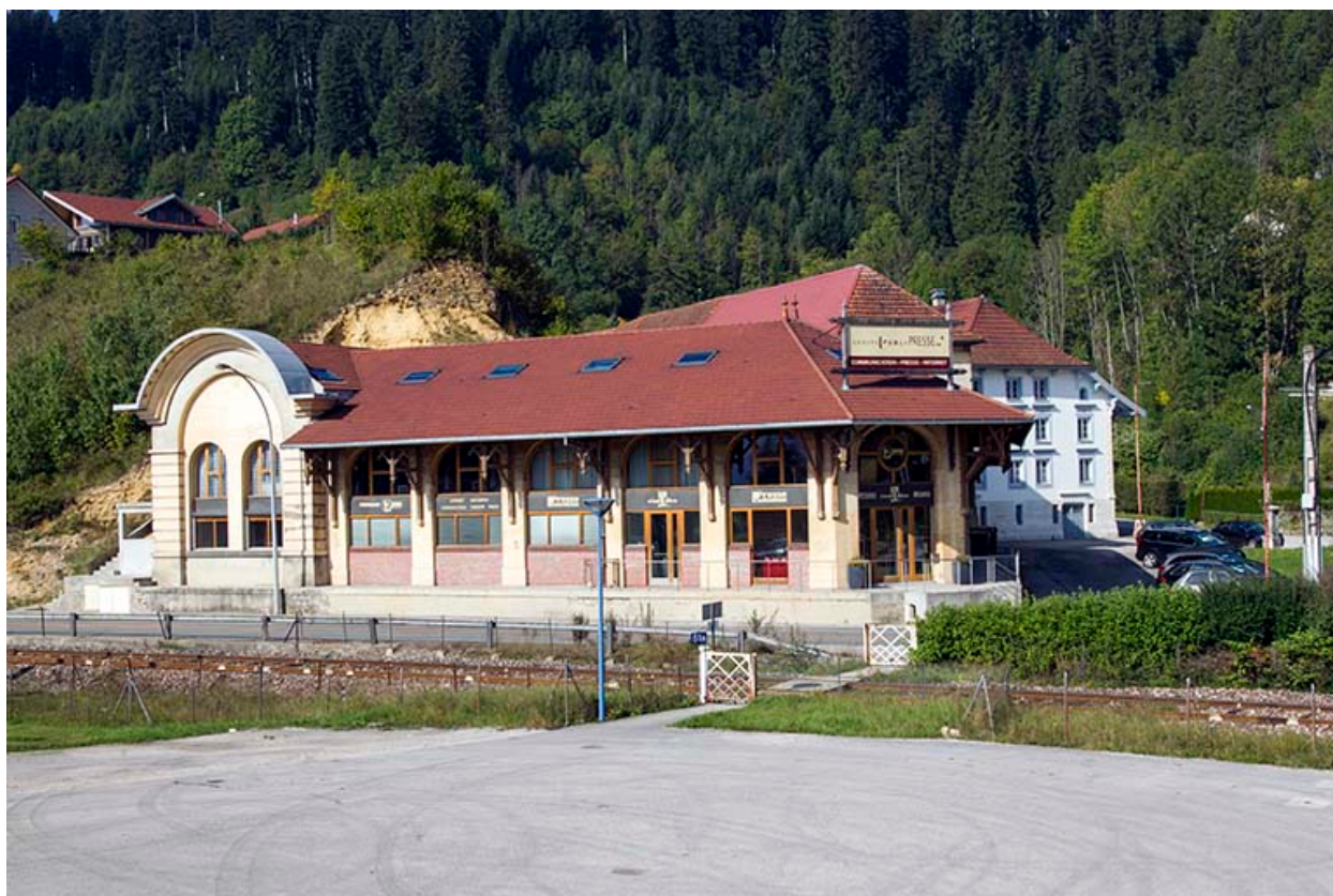
Atelier de conditionnement, depuis l'est.
