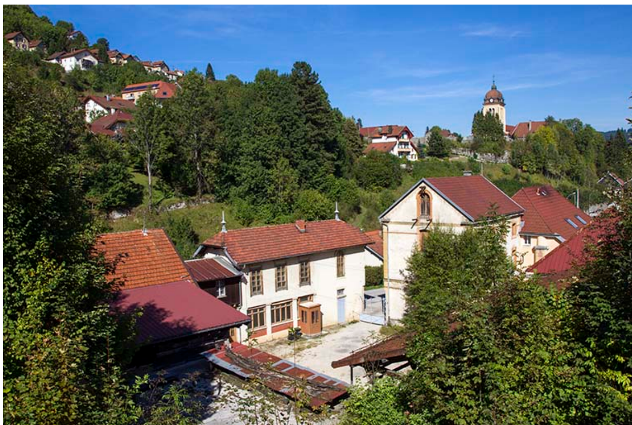
Vue d'ensemble plongeante, depuis le sud.
