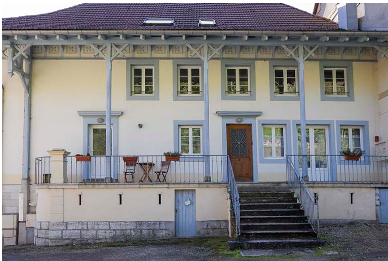
Premier atelier de fabrication : façade antérieure.
