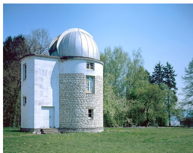
Vue d'ensemble, depuis l'ouest. Phot. Jérôme Mongreville IVR43_20022501245VA
