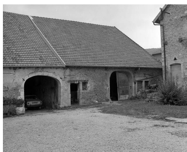
Ferme située à Scey-en- Varais, rue de l'Eglise. Phot. Yves Sancey IVR43_19802501144X
