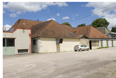
Halle de fonderie depuis le sud. Phot. Jérôme Mongreville IVR43_20087000750NUC2A
