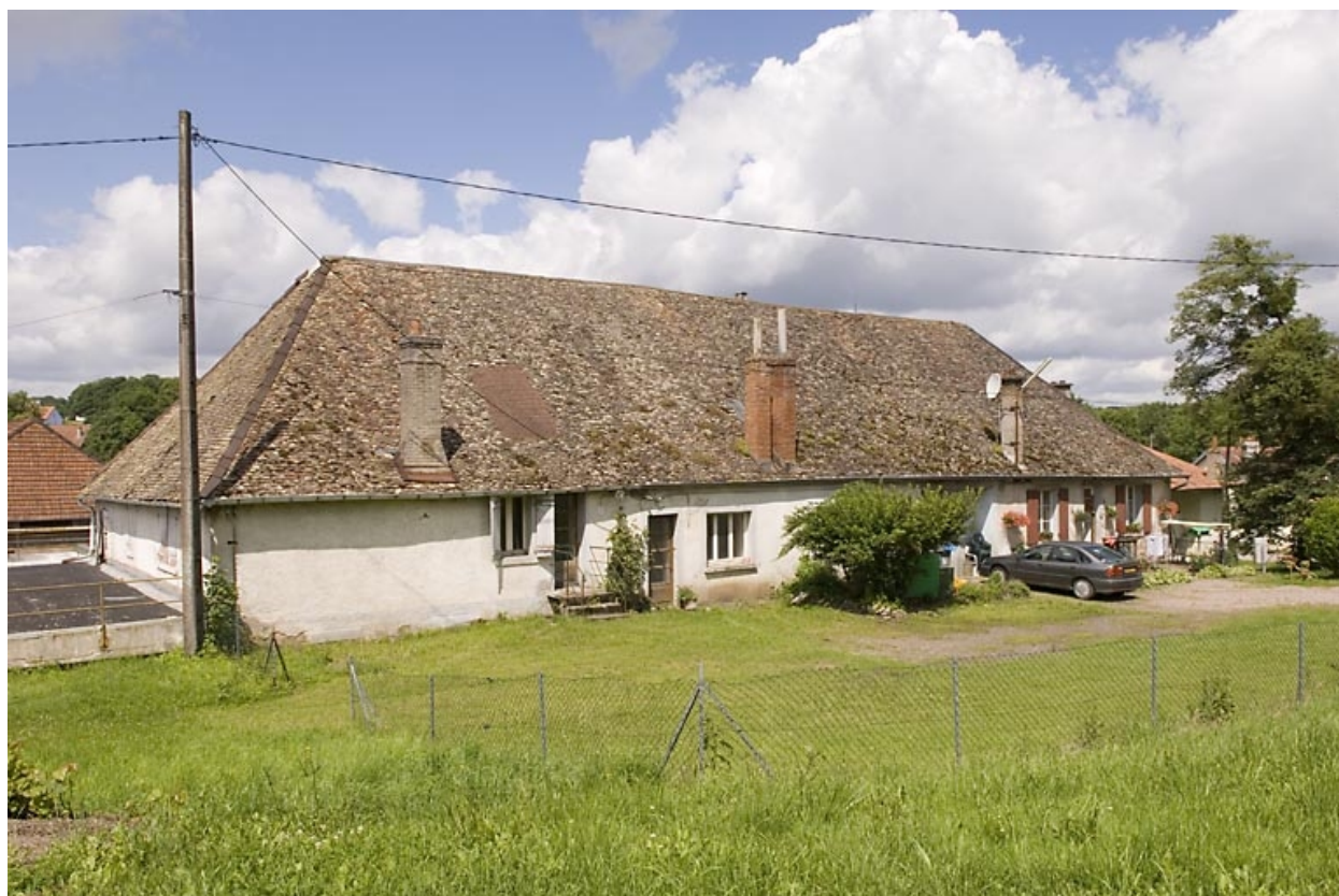
Logement ouvrier depuis l'est.
