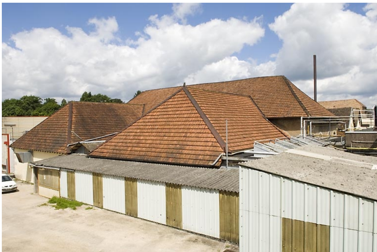
Halle de fonderie depuis le sud-est.
