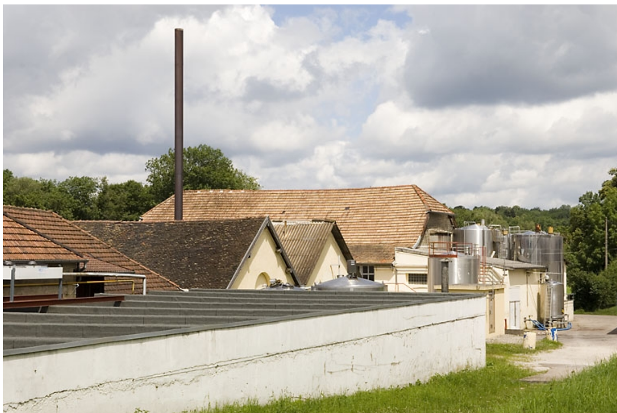
Vue arrière des bâtiments industriels.
