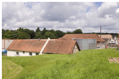
Vue sur les toitures depuis le sud-est. Phot. Jérôme Mongreville IVR43_20087000743NUC2A
