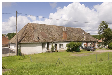
Logement ouvrier depuis l'est. Phot. Jérôme Mongreville IVR43_20087000742NUC2A
