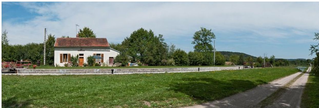
Vue d'ensemble du site d'écluse.
