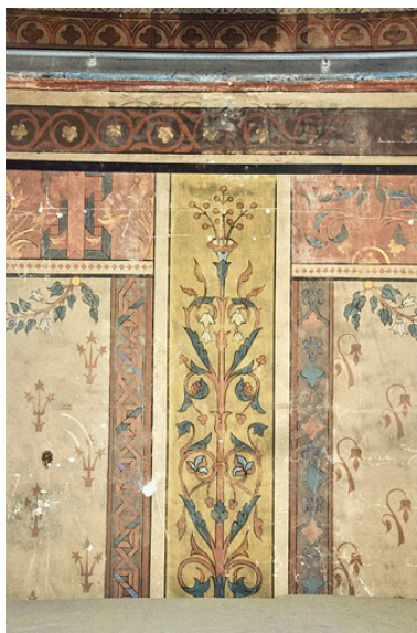
Nef, mur nord (1991) : peinture monumentale. Phot. Jean-Luc Duthu IVR26_19912103262ZA
