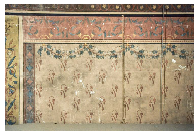
Nef, mur nord (1991) : peinture monumentale. Phot. Jean-Luc Duthu IVR26_19912103264ZA
