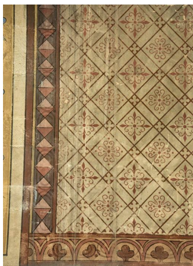
Nef, mur nord (1991) : peinture monumentale. Phot. Jean-Luc Duthu IVR26_19912103252ZA
