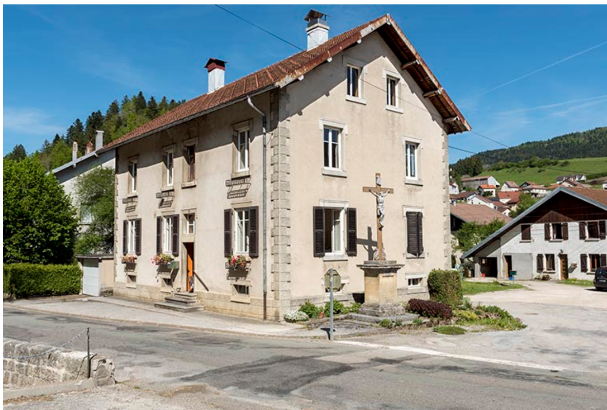
Façades antérieure et latérale droite.
