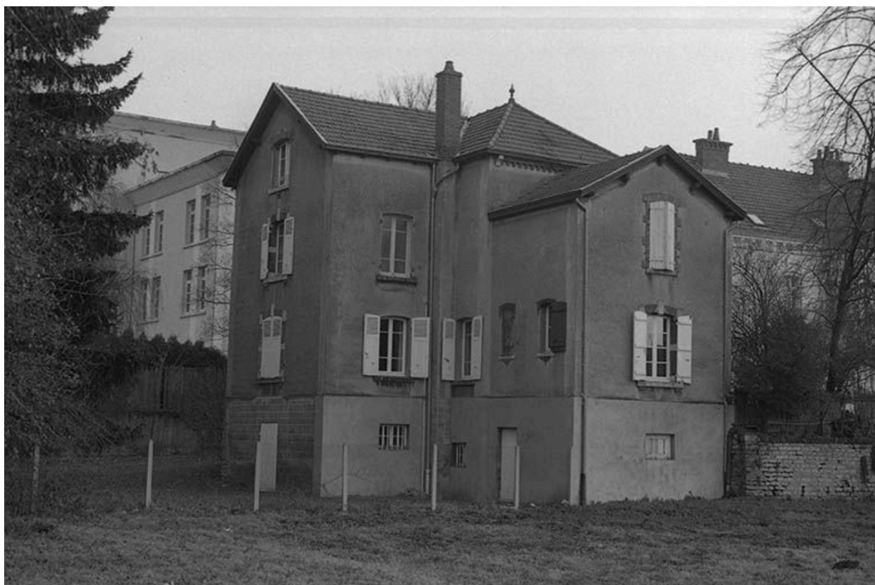
Salles de réunion , vues de l'Ouest.
