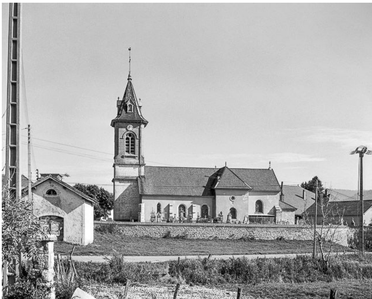
Façade latérale droite.
