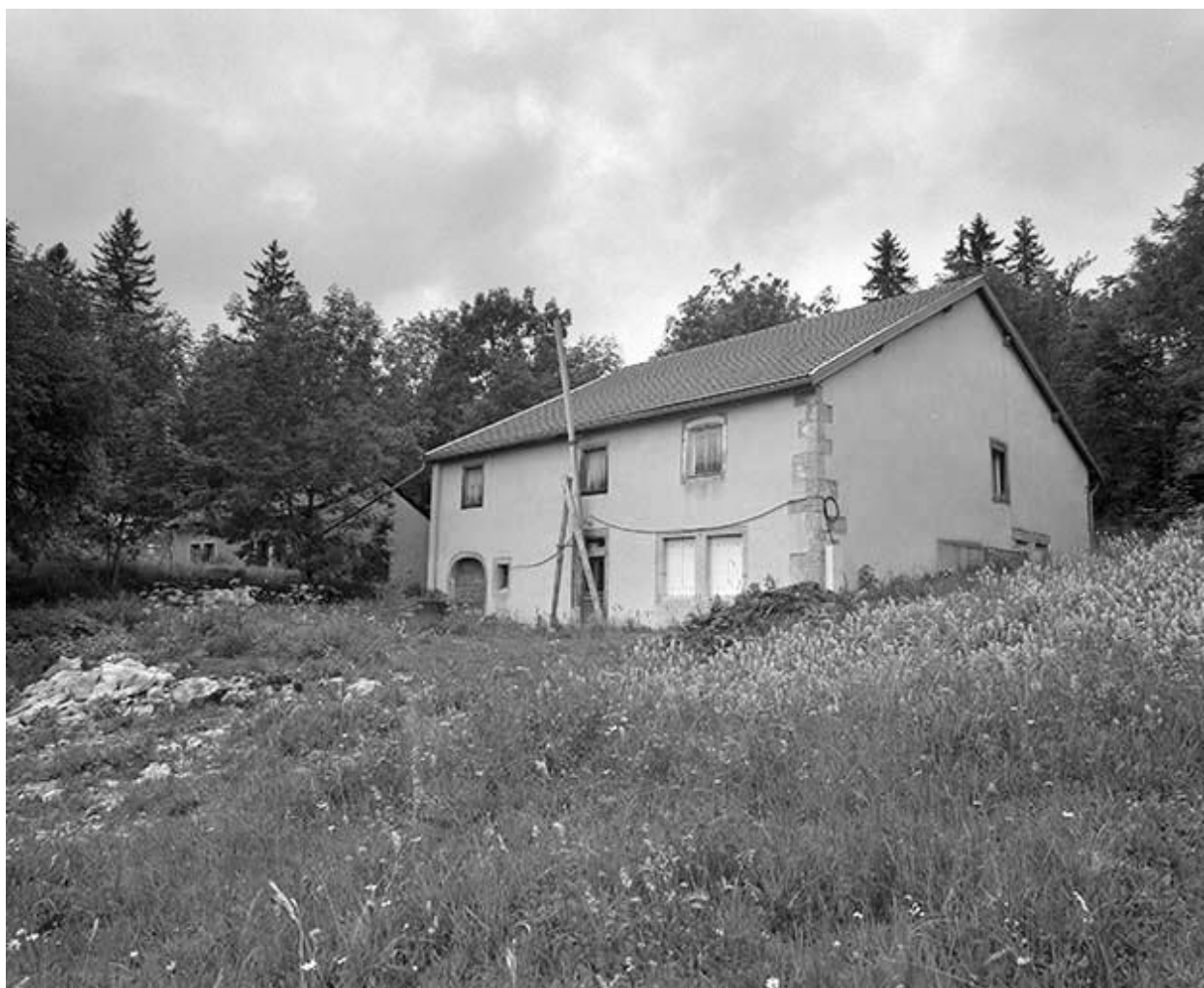
Ferme située au lieudit Ripaille.
