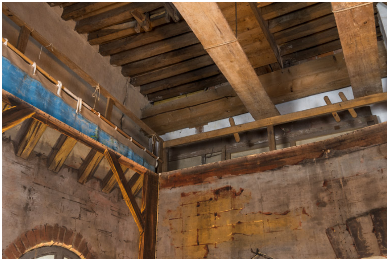
Machinerie : gril et palettes pour la fixation des fils.
