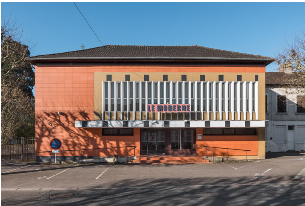
Corps d'entrée : façade antérieure.
