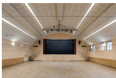
Salle et scène, depuis l'entrée. Phot. Pierre-Marie Barbe-Richaud IVR26_20257100069NUC4A
