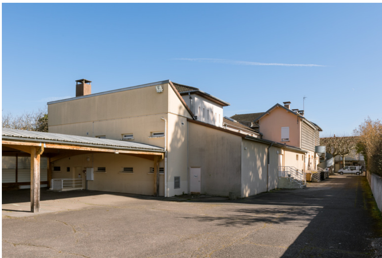
Vue d'ensemble, depuis les garages au sud-ouest.
