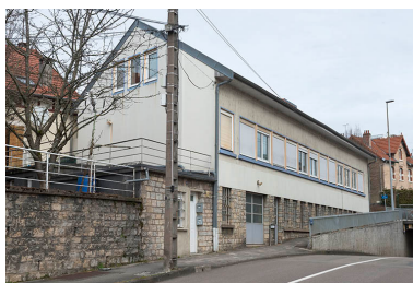
Façade est vue de trois quarts gauche. Phot. Jérôme Mongreville IVR43_20182500526NUC4A
