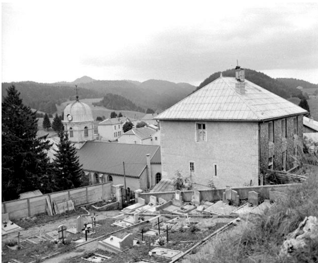
Extérieur : vue de situation depuis le sud-est.
