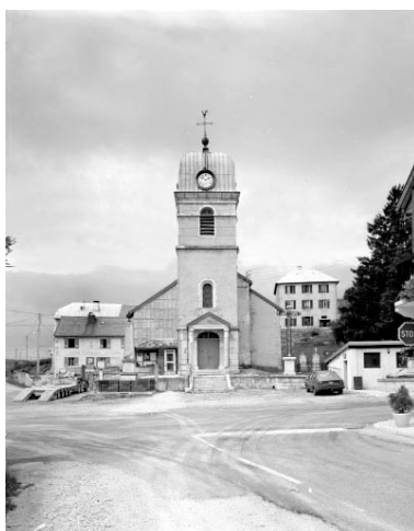
Extérieur : façade occidentale. Phot. Yves Sancey IVR43_19943900949V
