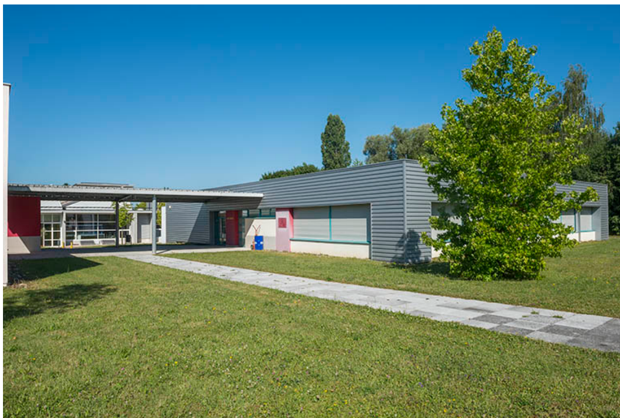
Angle sud-est du bâtiment de maintenance.(ex-Léger)
