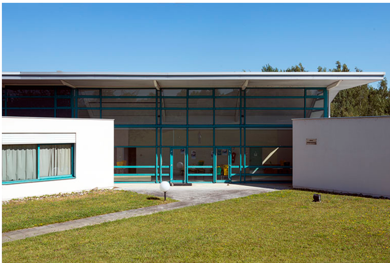
Détail façades sud des bâtiments de plasturgie.(ex-Léger)
