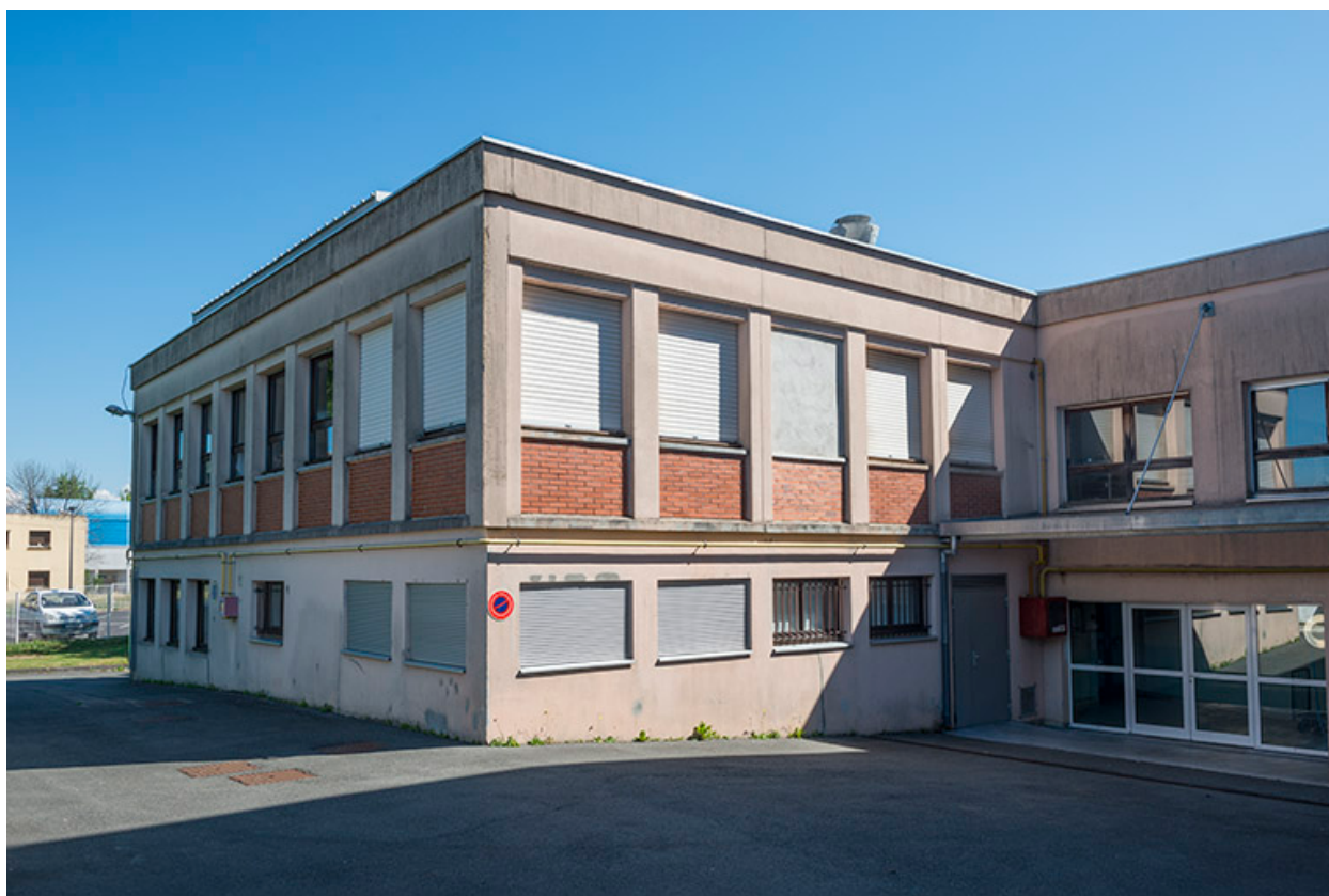
Façade ouest du bâtiment d'externat. (ex-Garnier)
