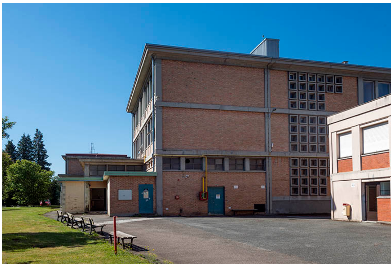
Façades antérieures (nord) du bâtiment d'externat. (ex-Garnier)
