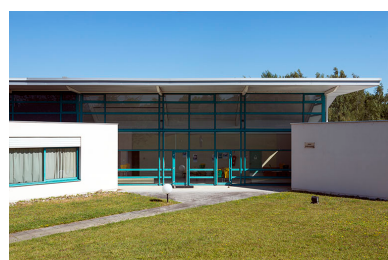
Détail façades sud des bâtiments de plasturgie.(ex-Léger)
