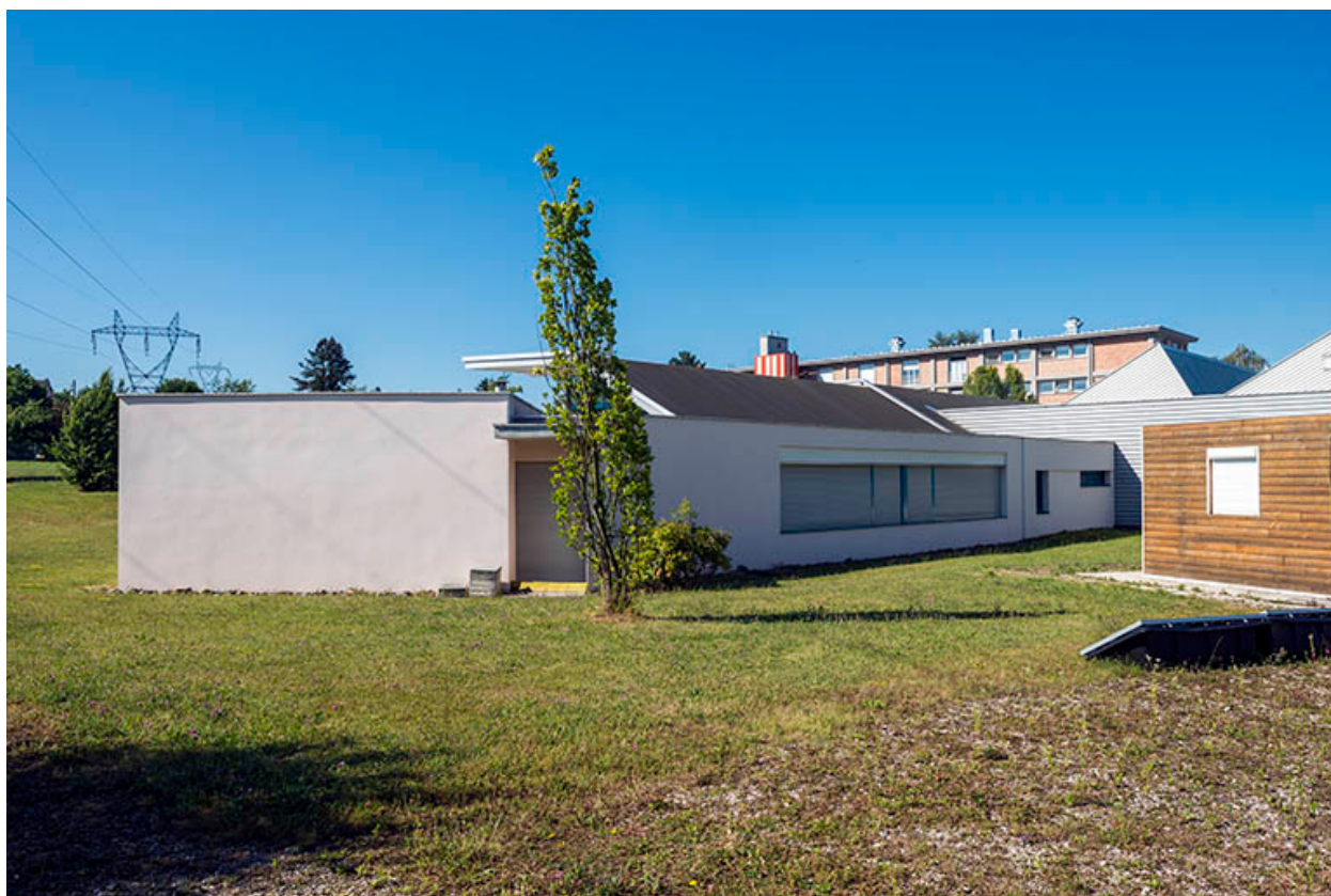
Façade postérieure nord de la plasturgie. (ex-Léger)
