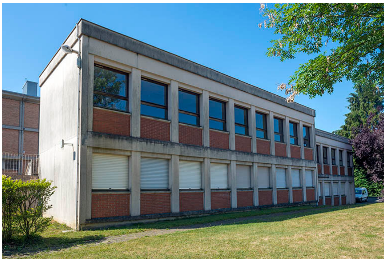
Façades antérieures (nord) du bâtiment d'externat. (ex-Garnier)
