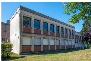
Façades antérieures (nord) du bâtiment d'externat. (ex-Garnier) Phot. Mary Ruffinoni IVR43_20142500663NUC4A
