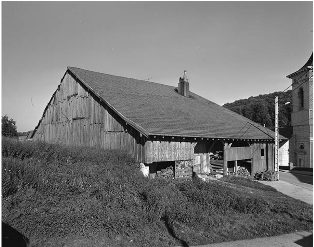
Façades postérieure et latérale gauche.
