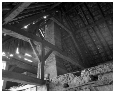
Conduit de cheminée et charpente. Phot. Michel Rosso IVR26_19862100168X
