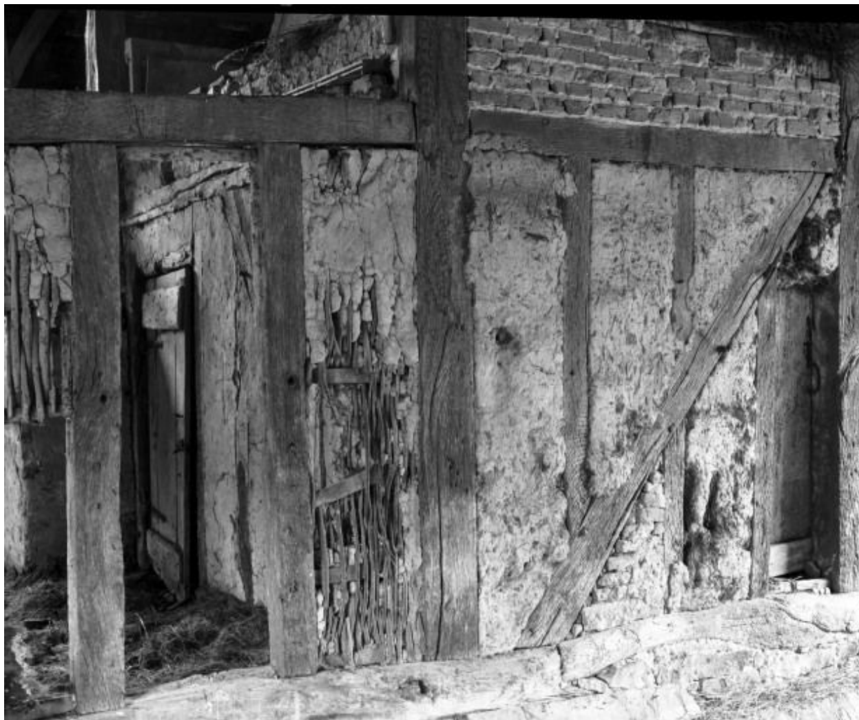
Aire de battage, détail du mur droit.
