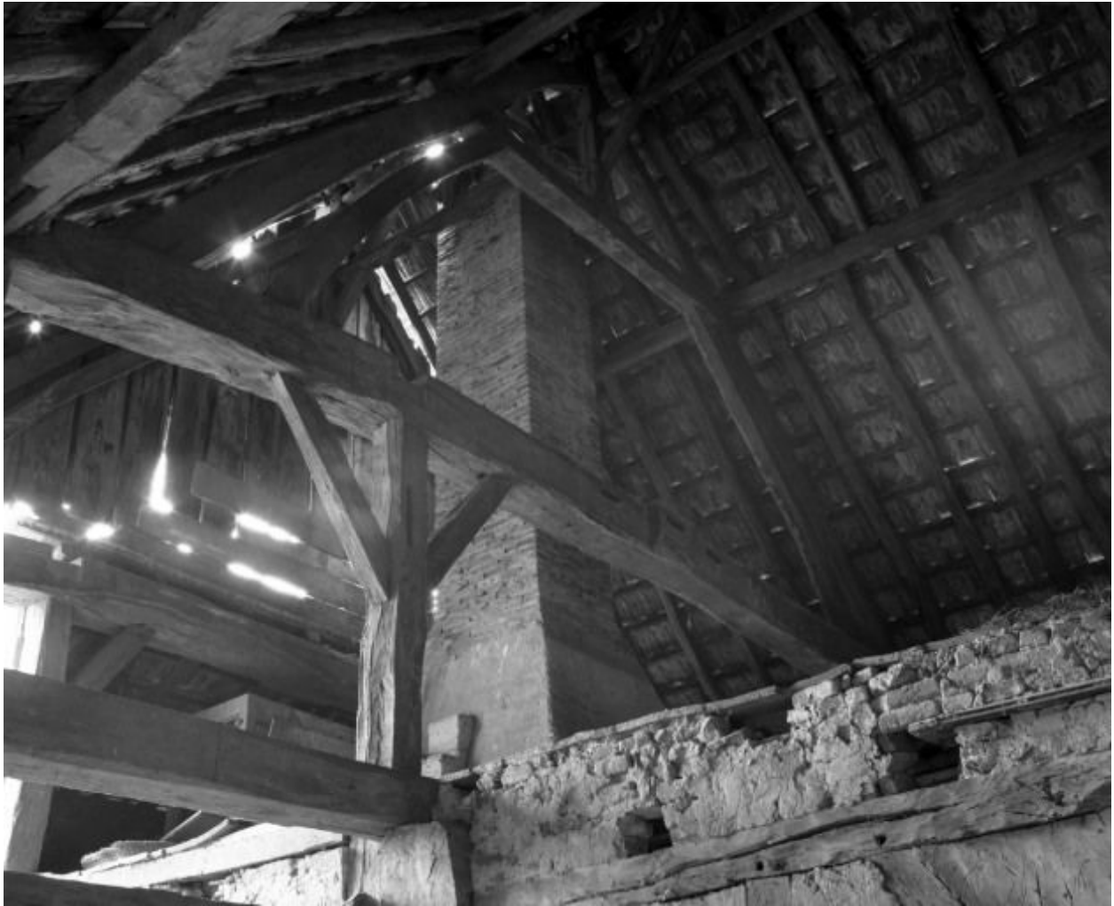
Conduit de cheminée et charpente.
