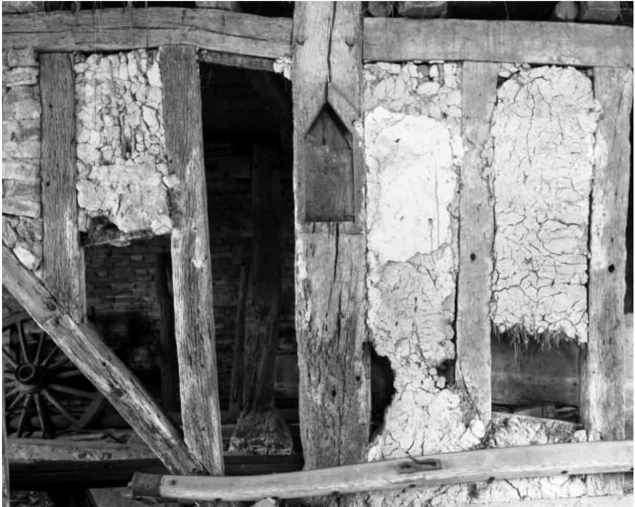
Aire de battage, mur gauche côté étable.
