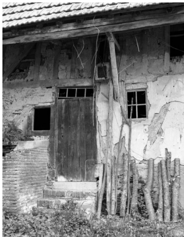
Façade du logis, détail. Phot. Michel Rosso IVR26_19862100163X
