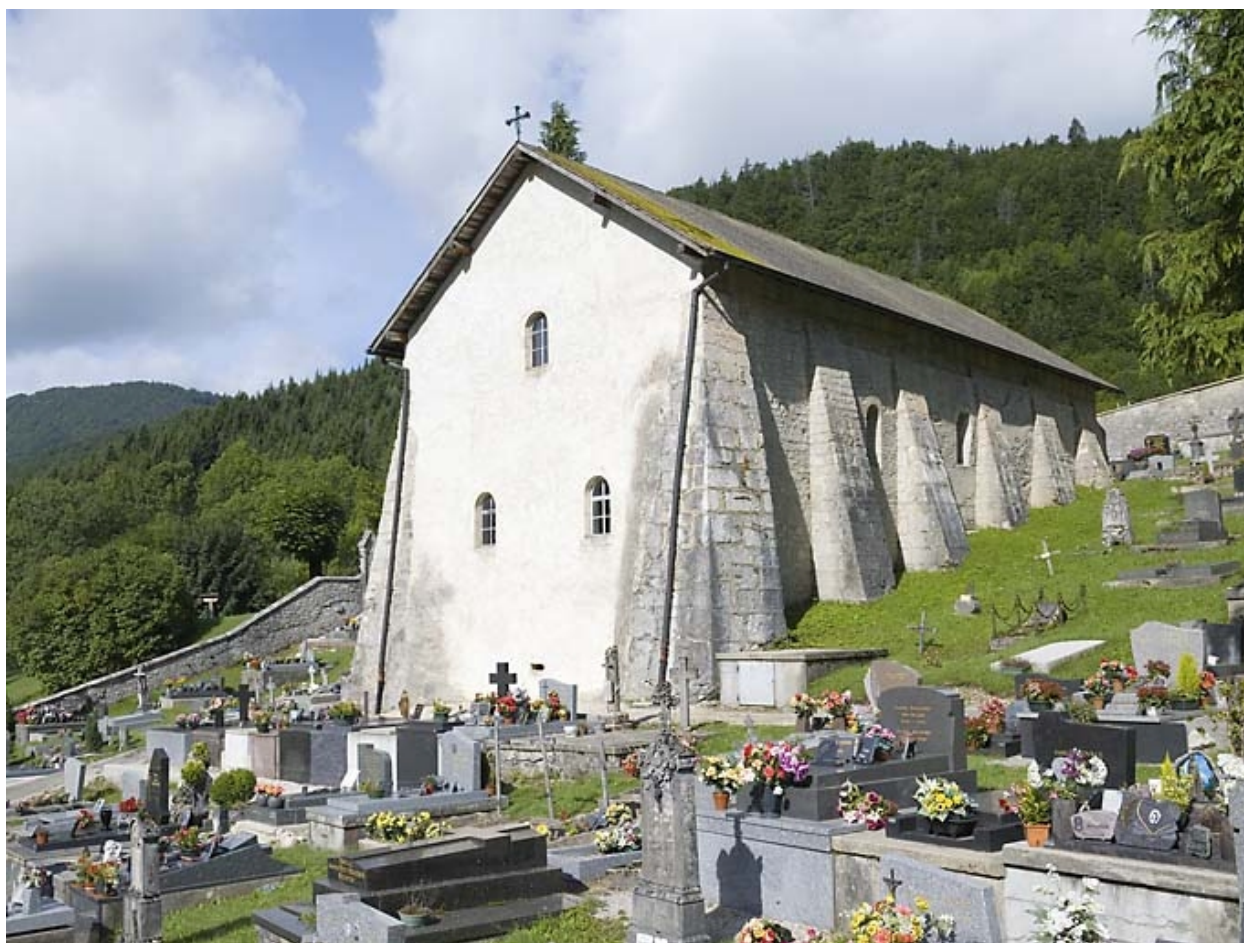
Vue générale rapprochée, depuis le sud-est.
