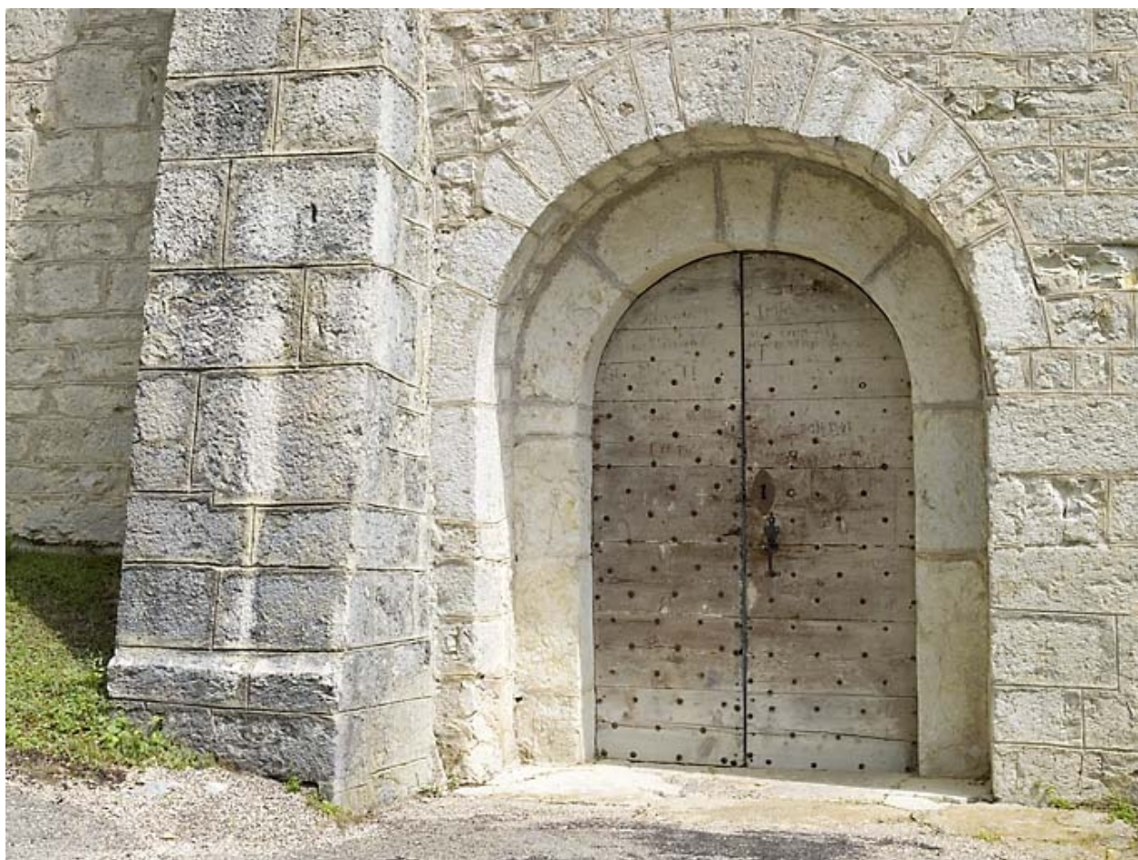
Façade sud : entrée.
