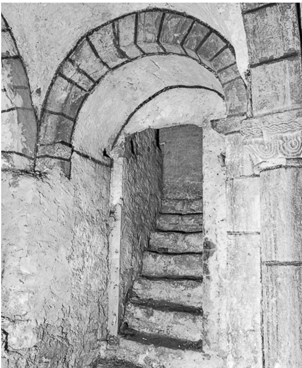
Crypte : escalier menant à la nef.
