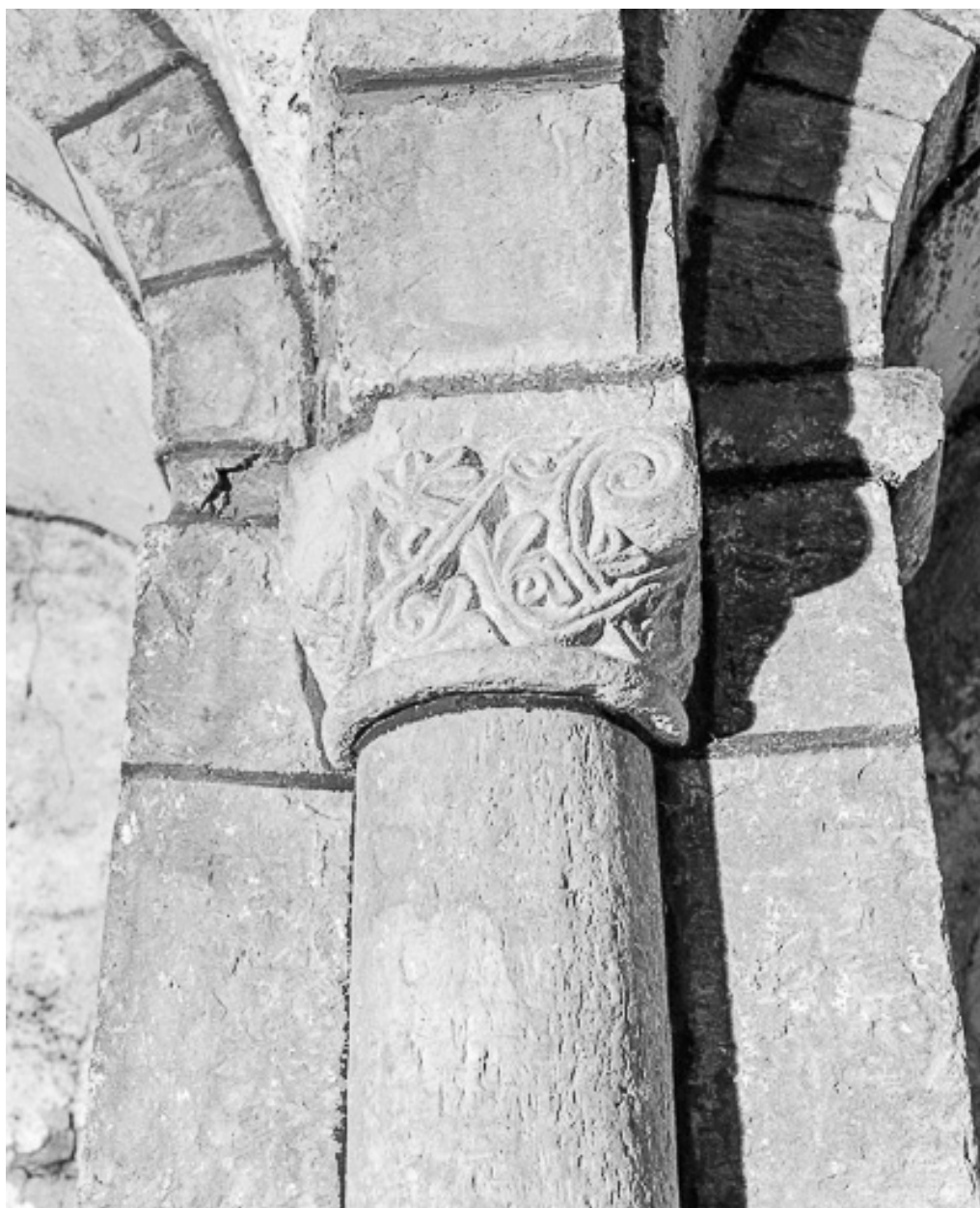
Crypte : chapiteau du mur ouest, côté nord.
