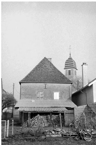
Façade postérieure. Phot. Laurent Poupard IVR43_19893900349Z
