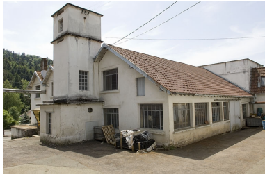
Vue depuis la cour. Phot. Jérôme Mongreville IVR43_20067000549NUCA
