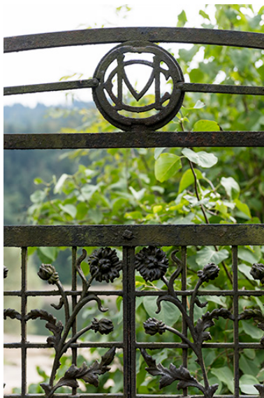
Porte de la clôture, au sud-est : initiales. Phot. Sonia Dourlot IVR43_20162501258NUC4A
