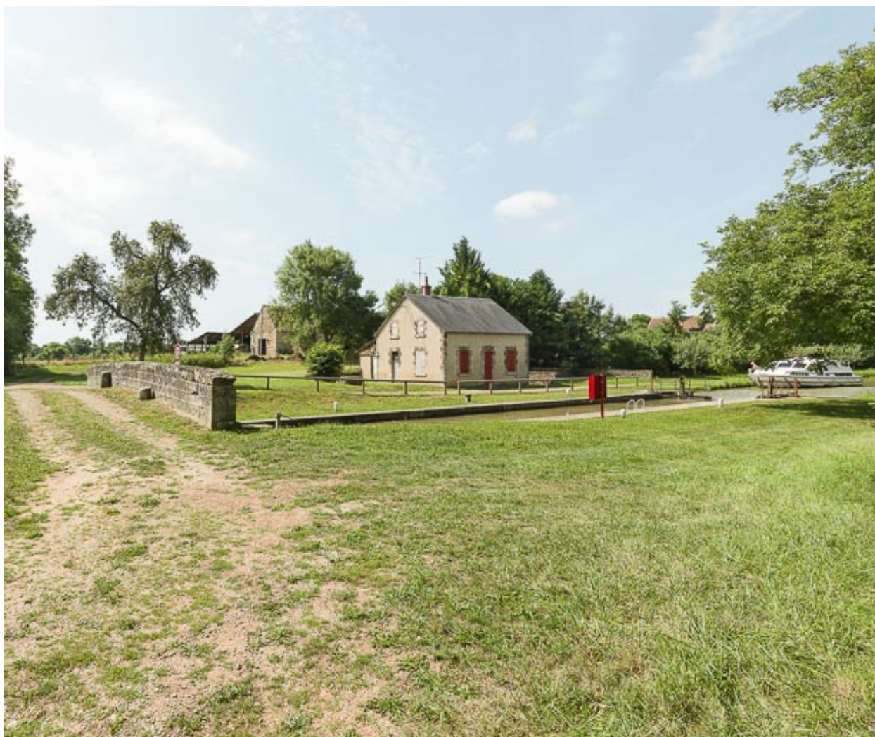
Vue du site d'écluse.
