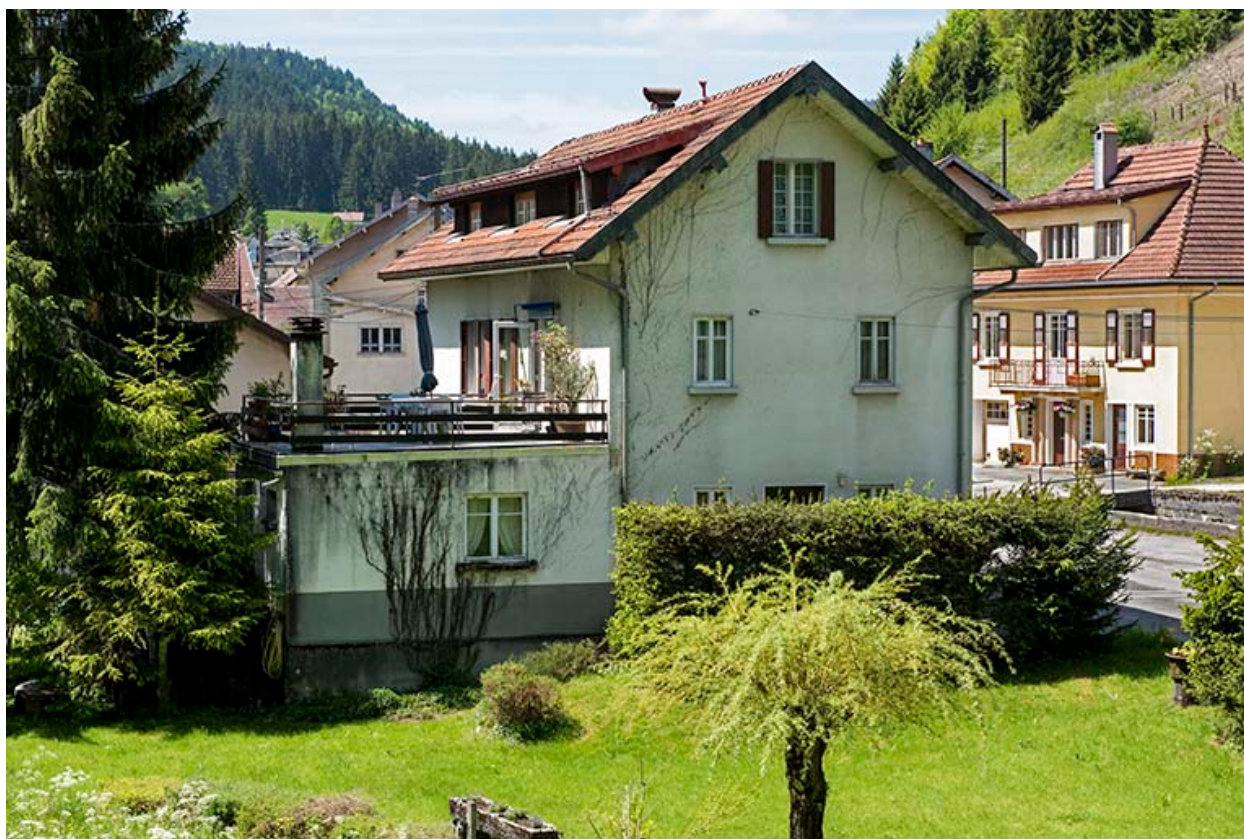
Façade postérieure et latérale gauche.
