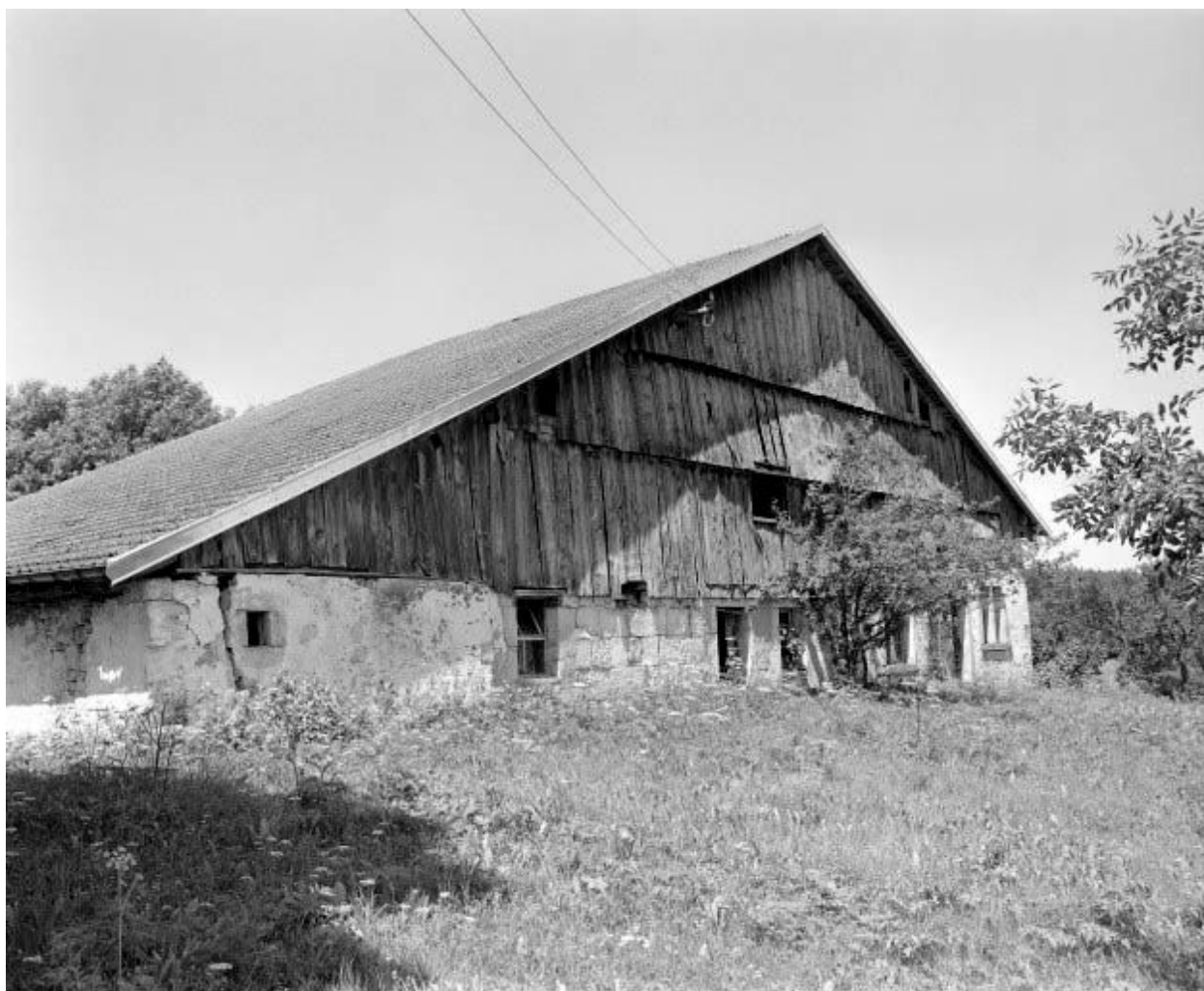
Ferme située rue de la Chapelle.
