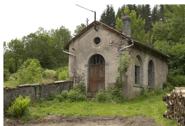
Ancienne centrale hydroélectrique. Phot. Jérôme Mongreville IVR43_20057000330NUCA
