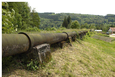
Détail de la conduite forcée. Phot. Jérôme Mongreville IVR43_20057000324NUCA
