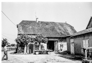
Ferme du 19e siècle cadastrée 1811 D2 : vue générale. Phot. Guy Forestier IVR43_19753900325Z
