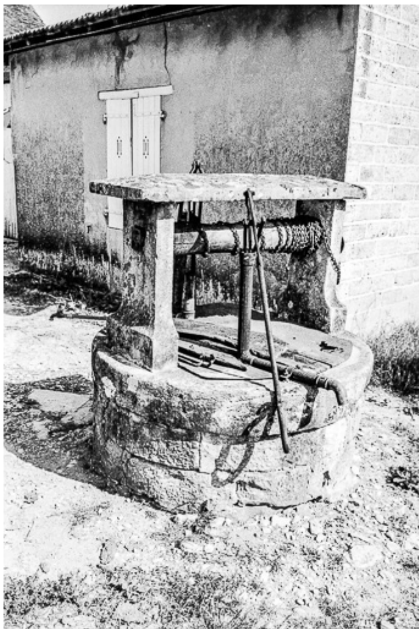
Ferme du 19e siècle cadastrée 1811 D2 : vue du puits.
