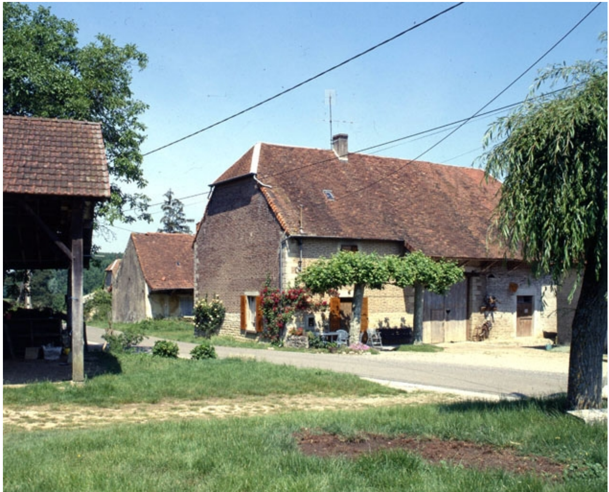
Ferme située 26 rue des Maquisards : vue d'ensemble.
