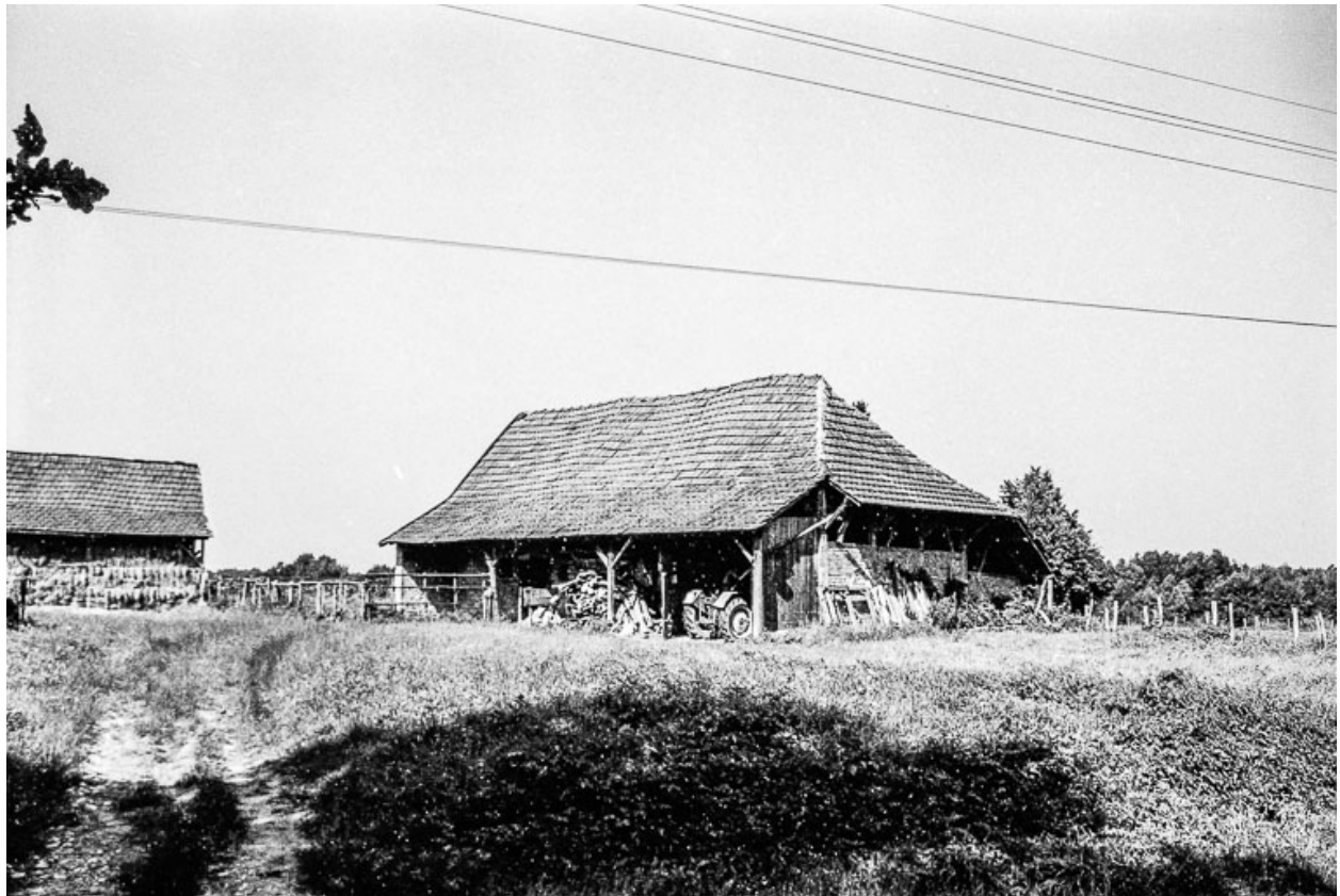
Façade postérieure d'une ferme.
