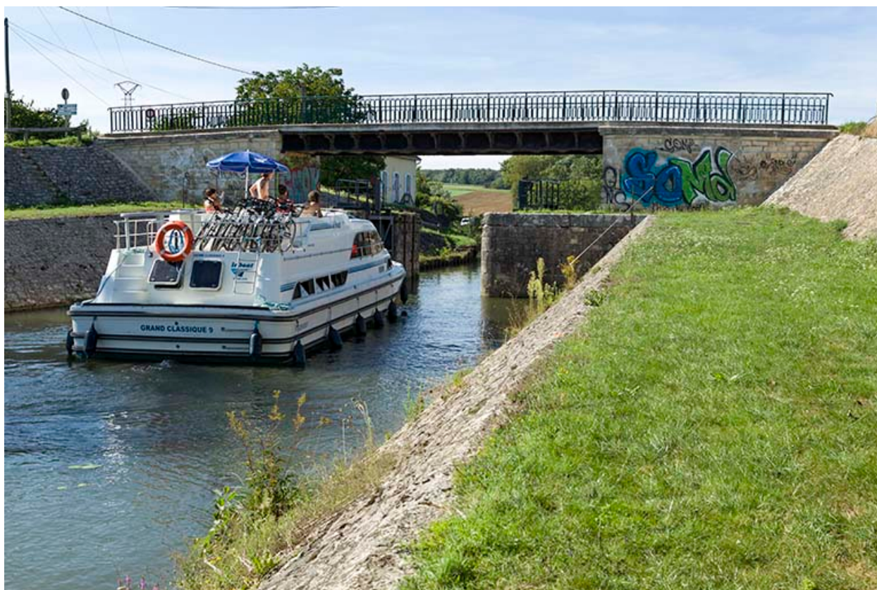
Bateau montant dans la porte de garde.
