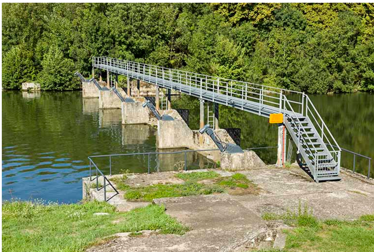
Vue de trois-quarts du barrage depuis la rive droite en amont. (nord-ouest)
