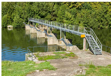
Vue de trois-quarts du barrage depuis la rive droite en amont. (nord-ouest) Phot. Sonia Dourlot IVR43_20157001505NUC2A
