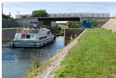
Bateau montant dans la porte de garde. Phot. Sonia Dourlot IVR43_20157001503NUC2A
