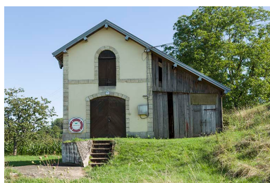
Vue du pignon nord du magasin avec date portée sur l'arc de la baie de l'étage. Phot. Sonia Dourlot IVR43_20157001506NUC2A
