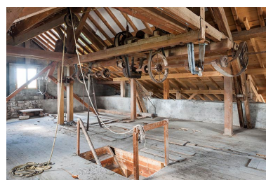
Etage en surcroît. Vue d'ensemble.
