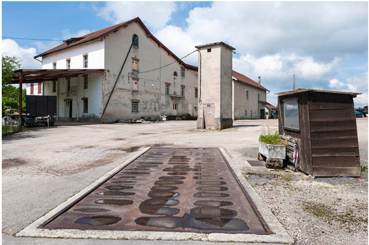
Vue d'ensemble depuis le pont bascule.
