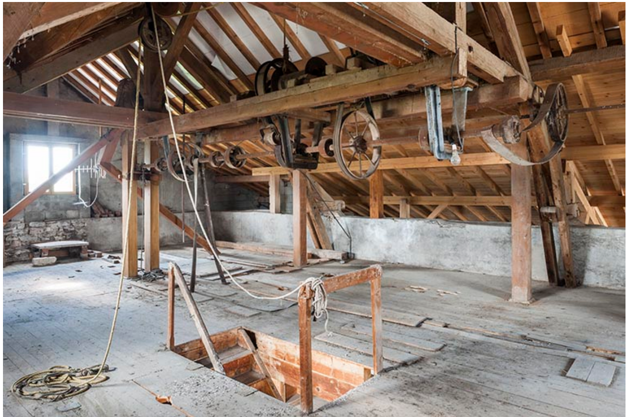
Etage en surcroît. Vue d'ensemble.
