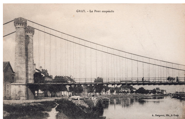
L'ancien pont suspendu de Gray, carte postale. Phot. Jérôme Mongreville, Autr. auteur inconnu IVR43_20197000441NUC4A
