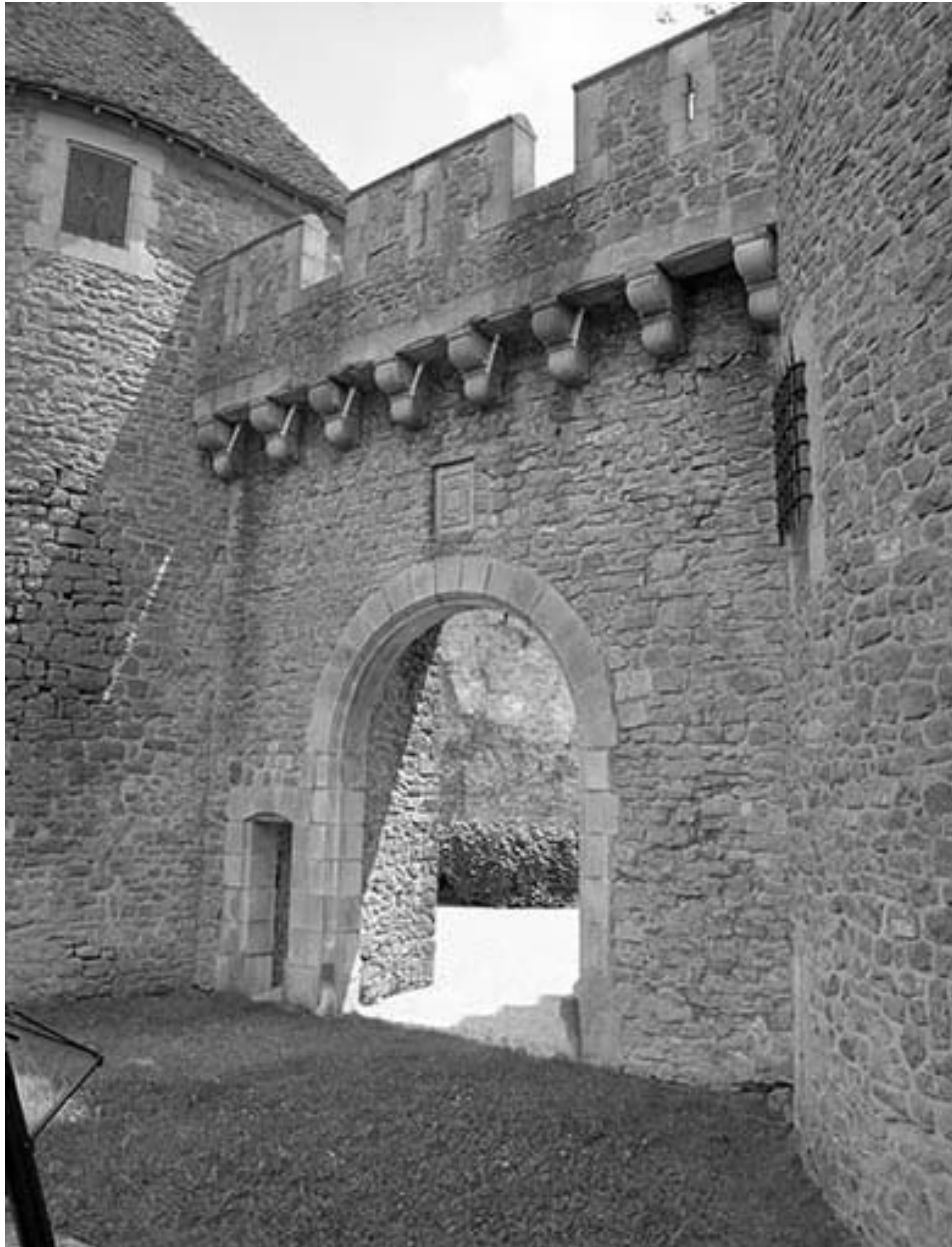
Portail nord : vue de trois quarts.
