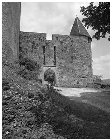
Portail sud. Phot. Yves Sancey IVR43_19813900243X
