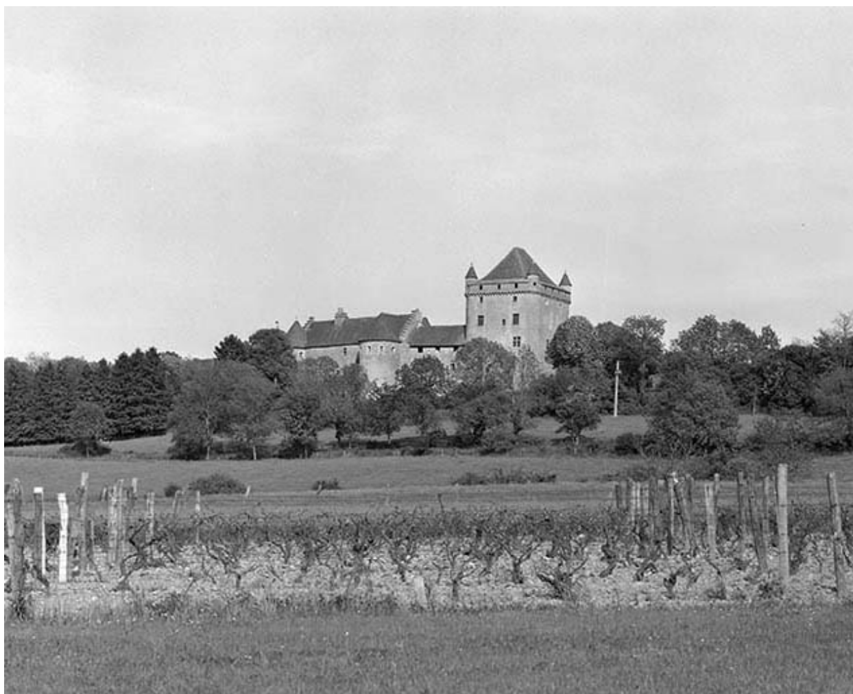
Façade ouest : vue éloignée.
