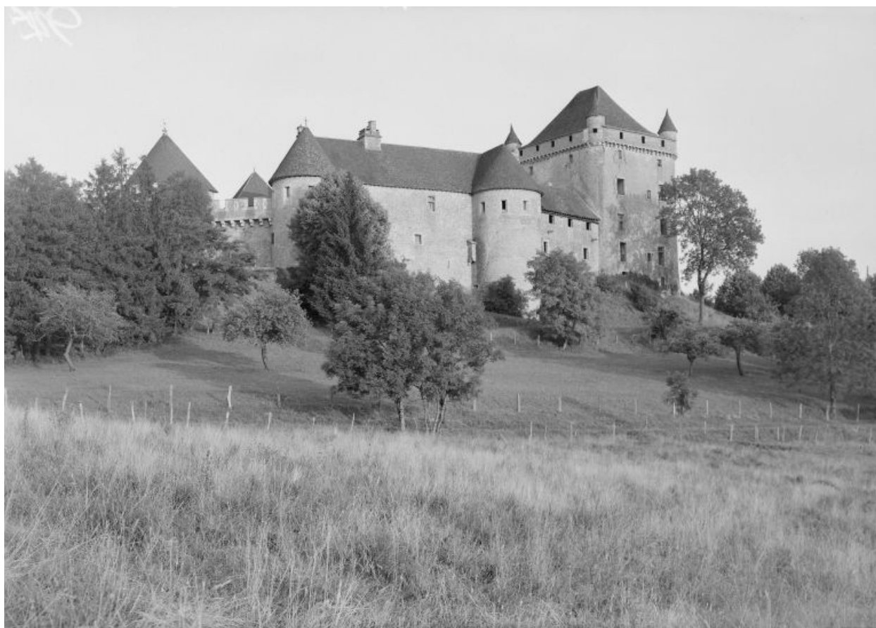
Façade ouest : vue d'ensemble.
