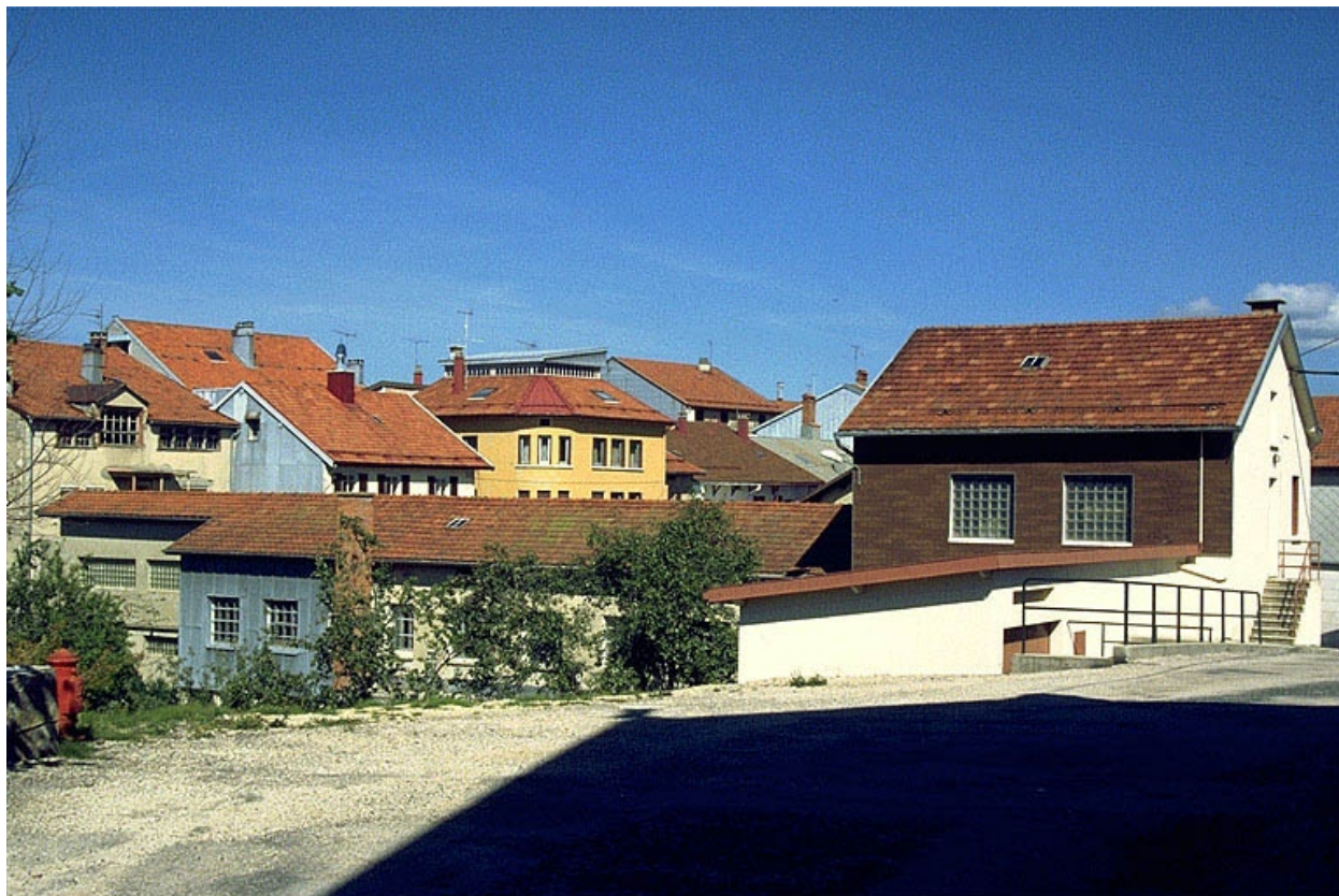
Façade postérieure de l'usine.
