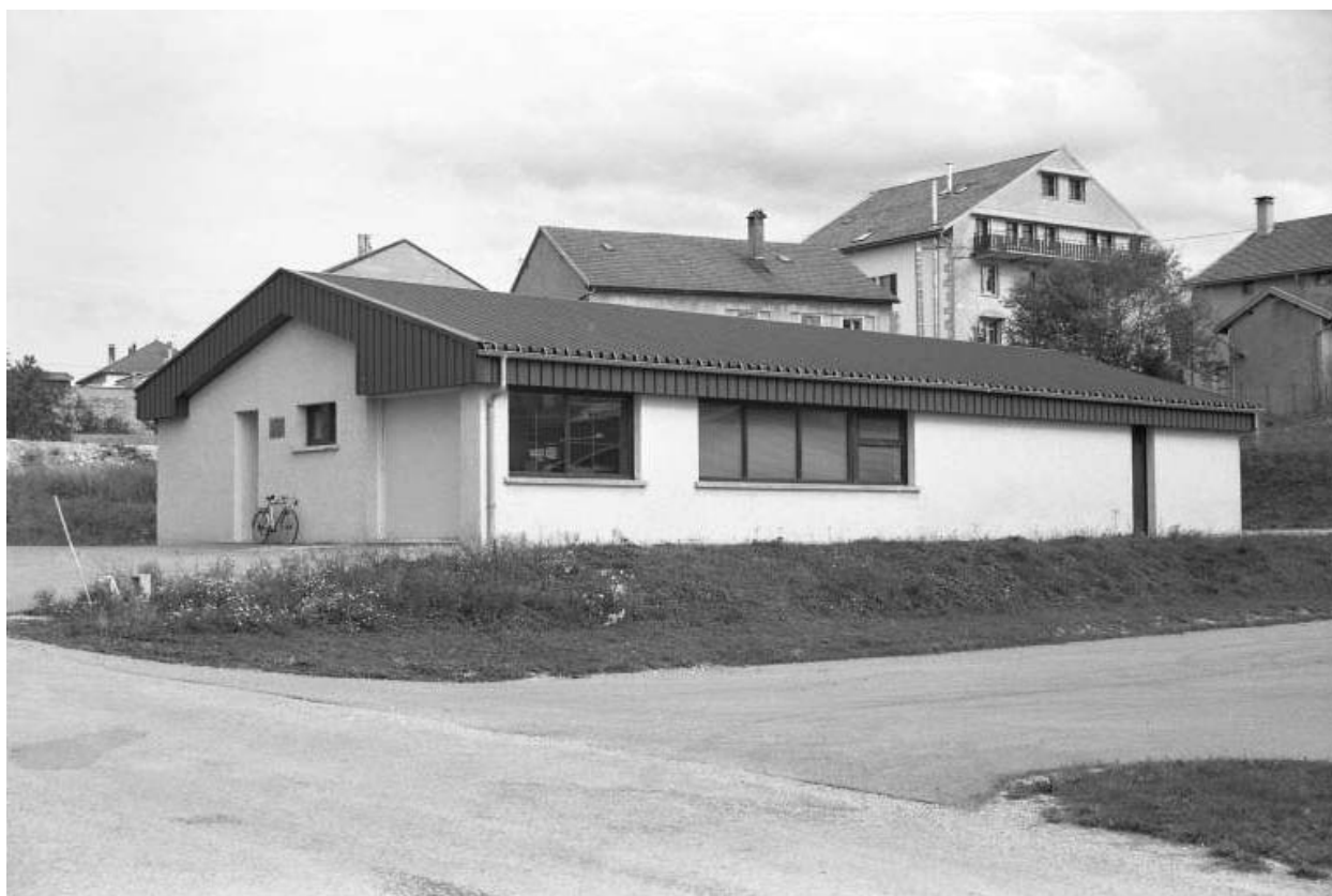
La nouvelle usine (rue Lacuzon).
