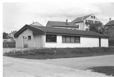
La nouvelle usine (rue Lacuzon). Phot. Laurent Poupard IVR43_19903900610Z
