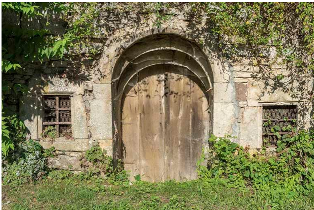
Entrée de cave sur rue
