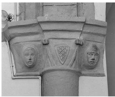
Intérieur : choeur, 2e chapiteau droit. Phot. Yves Sancey IVR43_19763900451X
