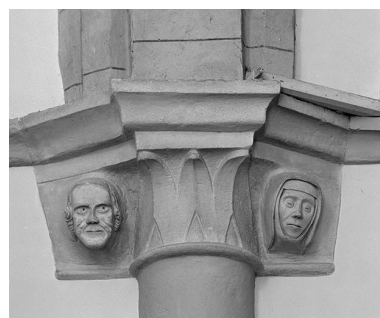
Intérieur : nef, 3e chapiteau gauche. Phot. Yves Sancey IVR43_19763900455X
