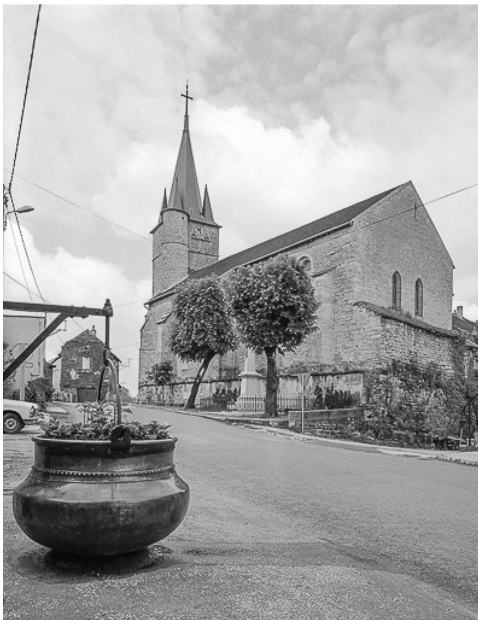
Extérieur : façade latérale droite et chevet.
