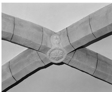
Intérieur : chef de voûte. Phot. Yves Sancey IVR43_19763900458X
