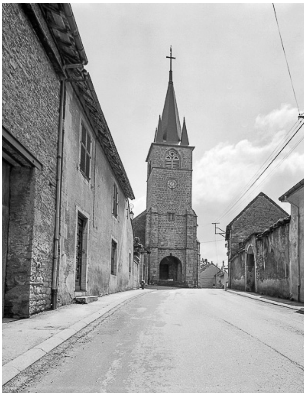
Extérieur : façade antérieure.
