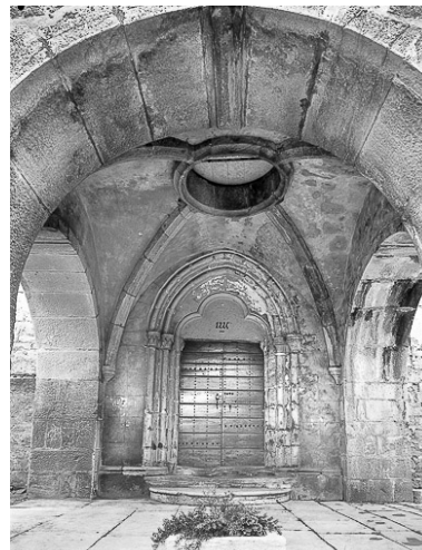
Extérieur : porche. Phot. Yves Sancey IVR43_19763900482V
