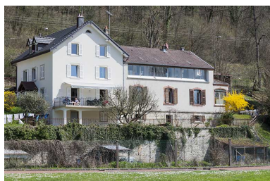
Façade ouest vue de trois quarts gauche. Phot. Jérôme Mongreville IVR43_20132500172NUC4A
