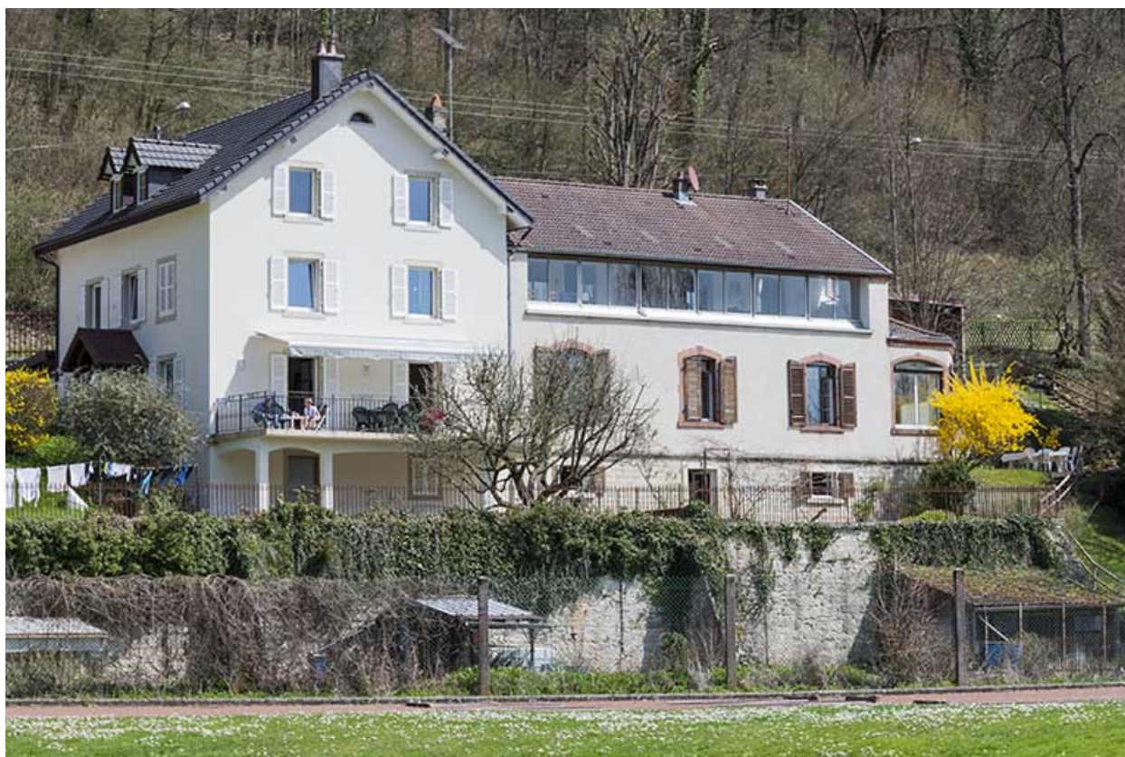
Façade ouest vue de trois quarts gauche.
