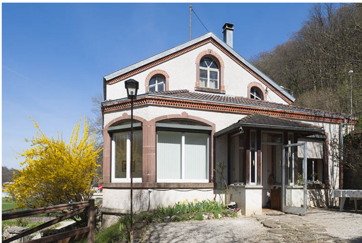
Pignon sud. Vestibule.
