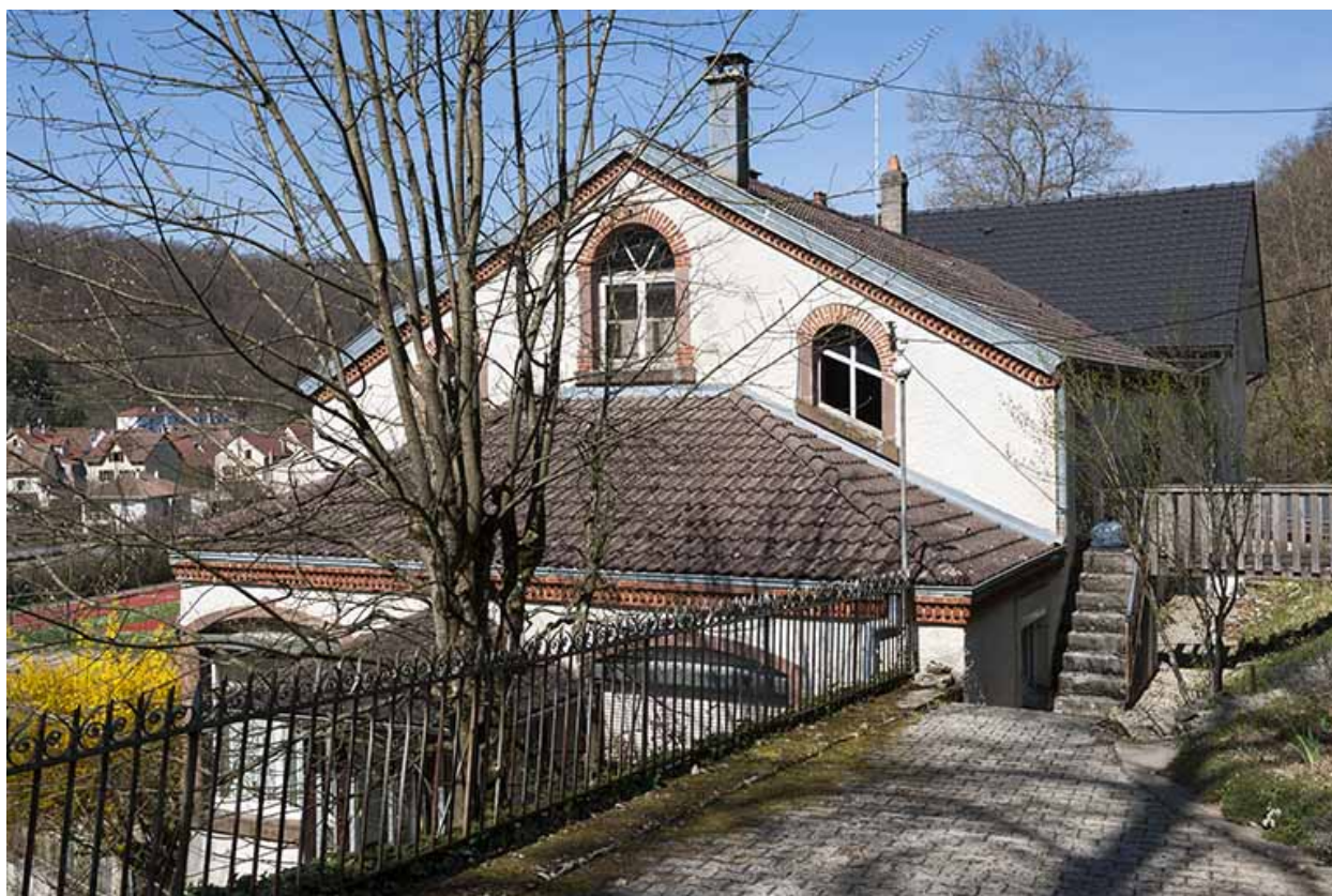
Pignon sud vu de trois quarts.
