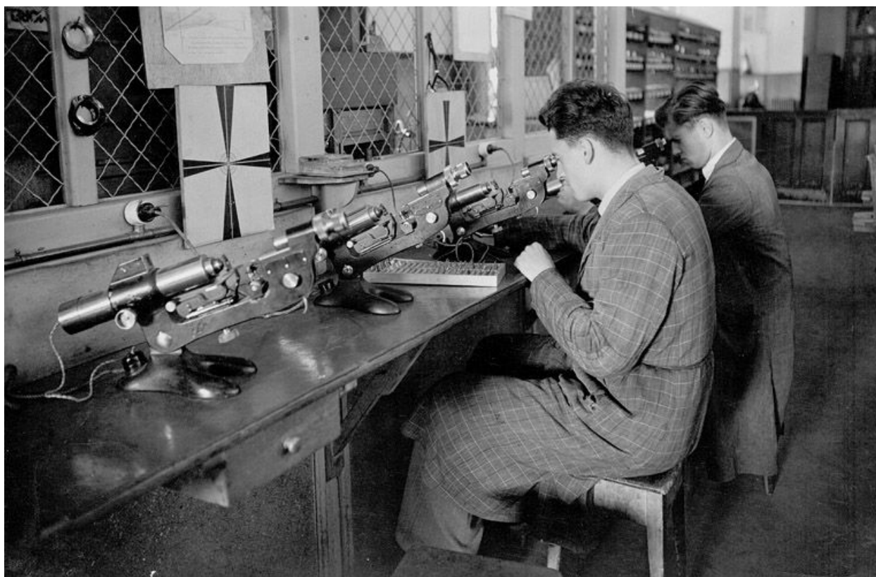
Batterie de focomètres, décennies 1930-1940
