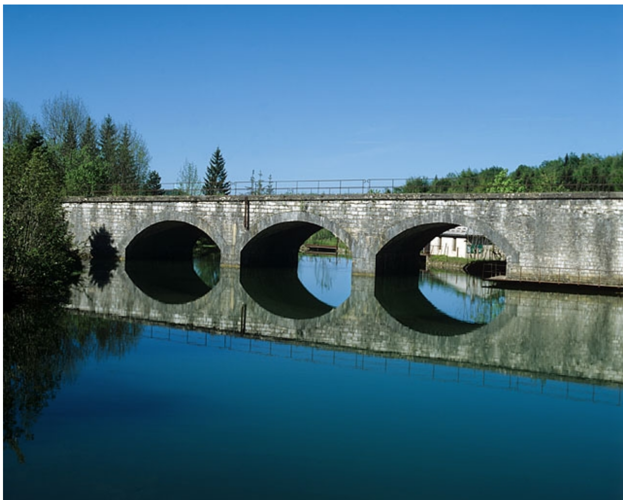
Viaduc : élévation orientale, depuis le nord-est.
