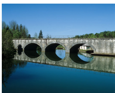
Viaduc : élévation orientale, depuis le nord-est. Phot. Yves Sancey
