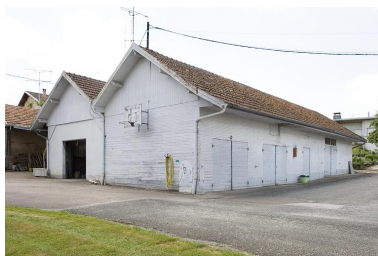
Dépendances. Phot. Jérôme Mongreville IVR43_20097000449NUC2A
