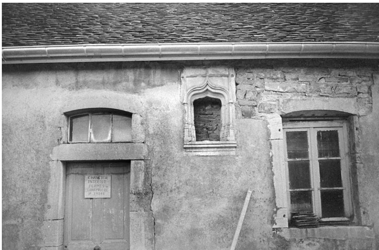
Maison : niche en façade.
