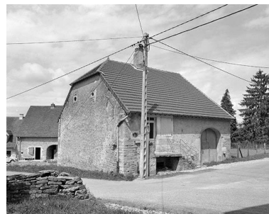
Ferme située chemin du Village. Phot. Yves Sancey IVR43_19813900231X
