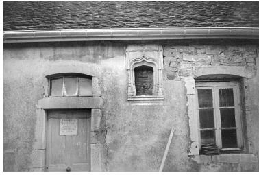
Maison : niche en façade.
