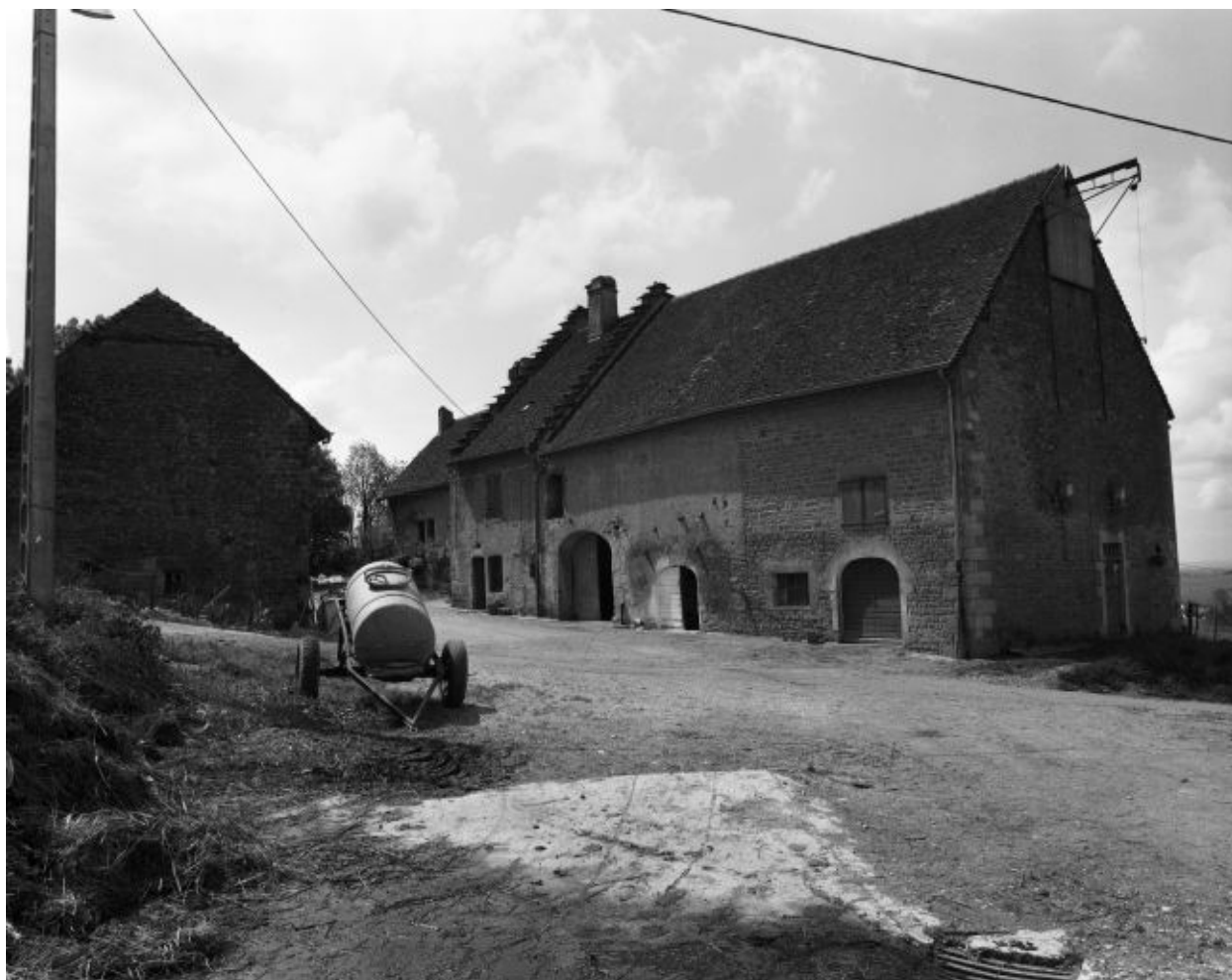
Ferme située chemin du Château.
