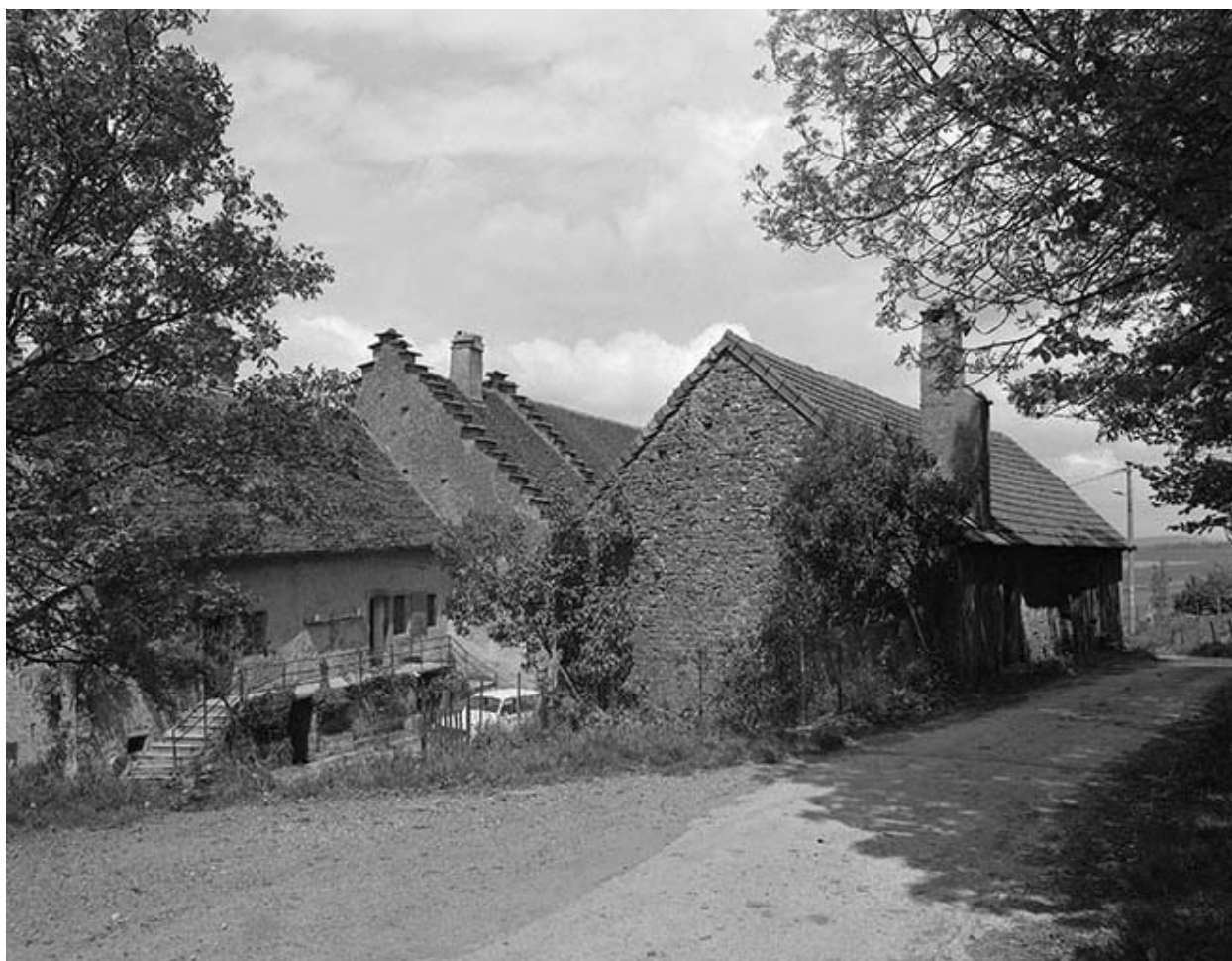
Ferme située chemin du Château.
