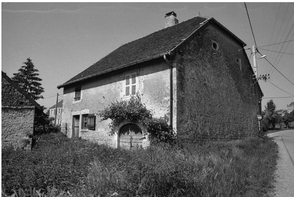
Ferme située le long du chemin vicinal ordinaire du Pin à Montain.
