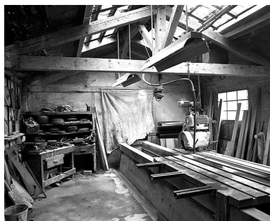
Débiteuse-moulreuse sud : vue d'ensemble. Phot. Yves Sancey IVR43_19933900344X
