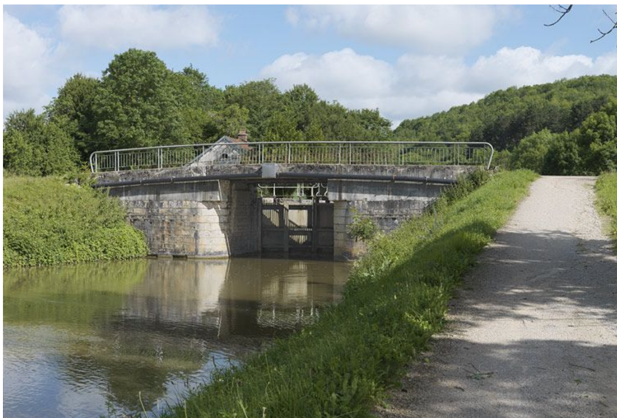
Vue d'ensemble du pont sur écluse.
