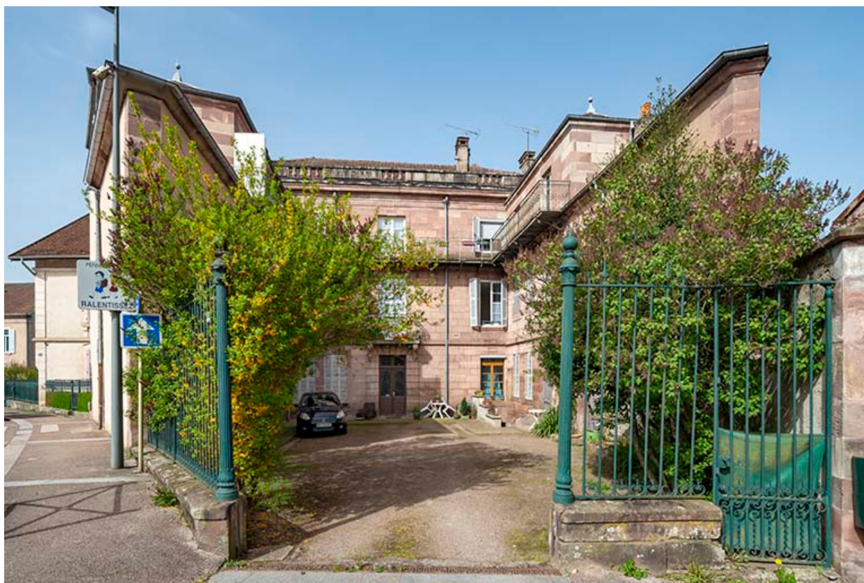
Façade sur la cour.
