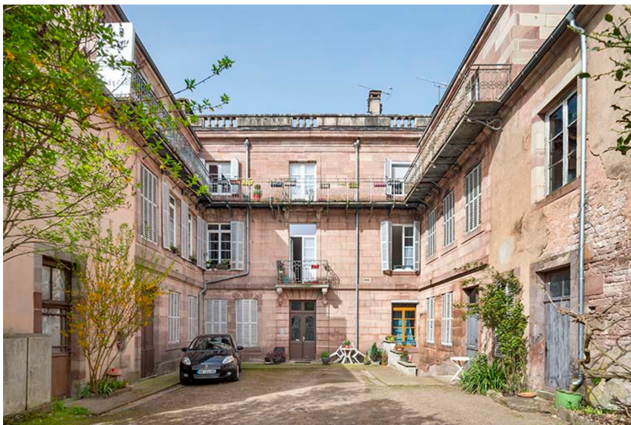
Façade sur la cour.
