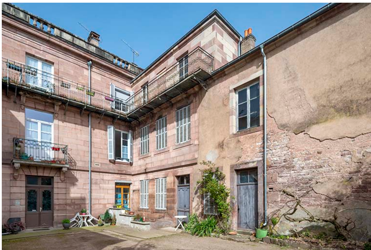
Façade sur la cour.
