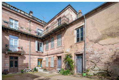
Façade sur la cour.
