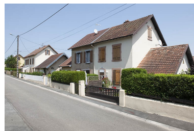
Maisons jumelées. Phot. Jérôme Mongreville IVR43_20122501767NUC4A
