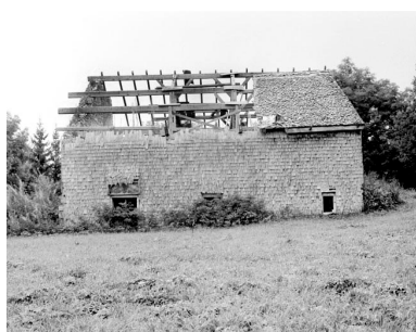
Les Bouchoux, ferme : vestiges de couverture en tavaillons. Phot. Jérôme Mongreville IVR43_19943900878X
