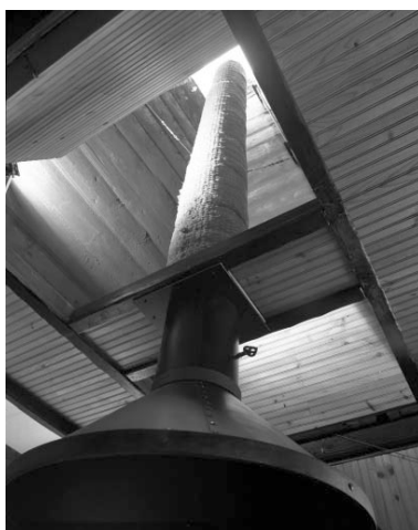
Les Moussières, ferme : intérieur du conduit de la cheminée en bois, un nouveau conduit isolé a été ajouté pour la cheminée actuelle. Phot. Yves Sancey IVR43_19943901048X
