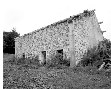
Les Bouchoux, ferme située au lieu-dit Sur Beau Regard : appareillage peu soigné de moellons. Phot. Jérôme Mongreville IVR43_19943900877X
