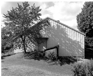
La Pesse, ferme située au lieu-dit Sur les Couronnes : facade gauche recouverte d'un essentage de zinc. Phot. Jérôme Mongreville IVR43_19943900713X
