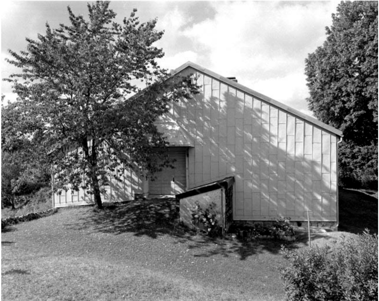
La Pesse, ferme située au lieu-dit Sur les Couronnes : facade gauche recouverte d'un essentage de zinc.
