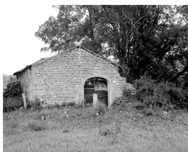
Les Bouchoux, ferme située au lieu-dit La Combe de Léary : pignon d'une ancienne ferme avec appareillage soigné. Phot. Jérôme Mongreville IVR43_19943900872X
