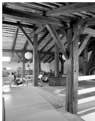
Les Moussières, ferme : grange haute et charpente sur poteaux. Phot. Yves Sancey IVR43_19943901055X
