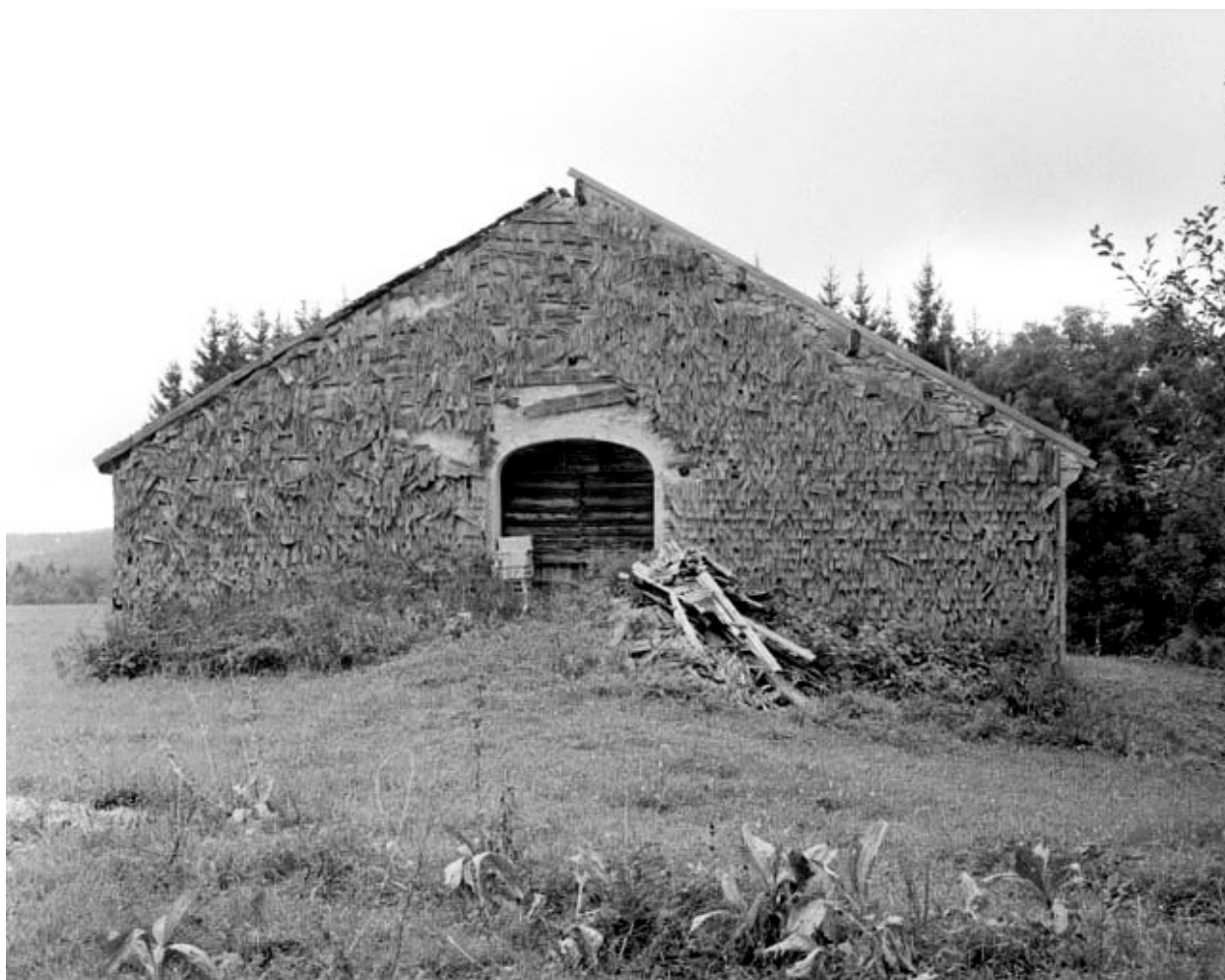
Les Bouchoux, ferme située au lieu-dit Sur Beau Regard : face gauche d'une ferme couverte d'un essentage de tavaillons.
