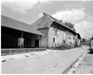
Ferme située rue de la Forge. Phot. Bernard Lardière IVR43_19782500250X
