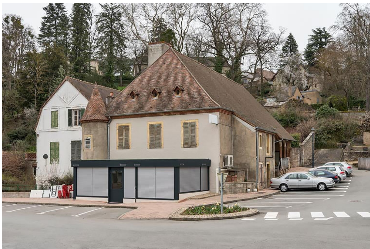
Vue actuelle depuis le sud-ouest.
