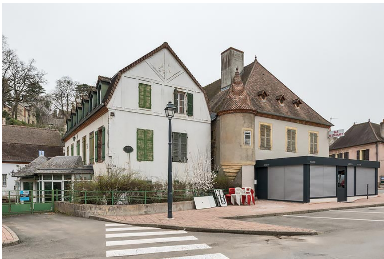
Vue actuelle depuis l'ouest.
