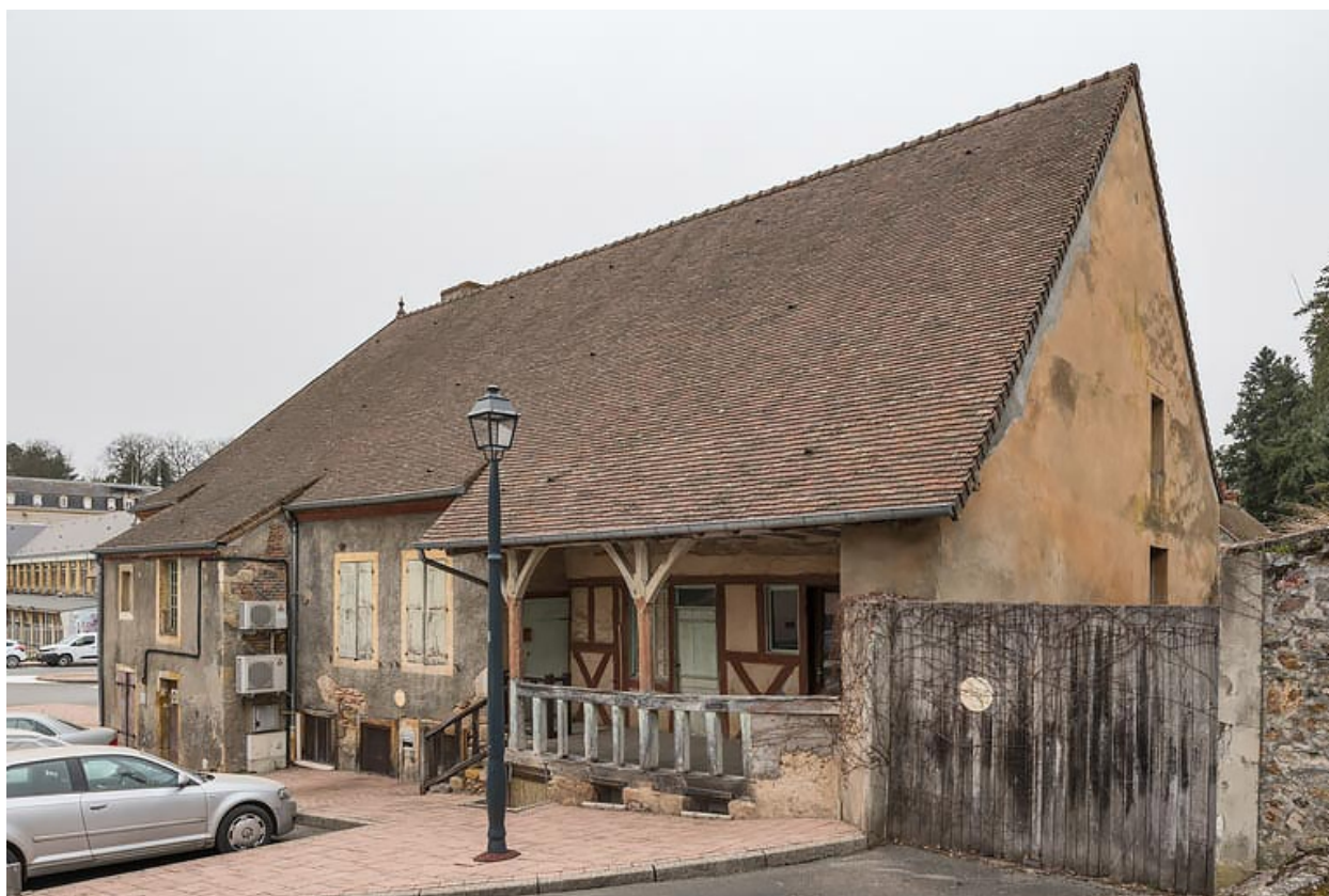
Vue actuelle depuis l'ouest.
